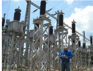
Gambar 10. Memeriksa dan Menguji Instalasi Gardu Induk
