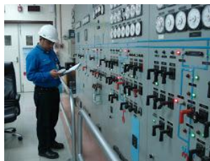
Gambar 12. Memeriksa dan Menguji Performance Sebuah Instalasi Pembangkit Tenaga Listrik
