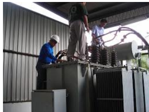
Gambar 19. Memeriksa dan Menguji Performace Transformer
