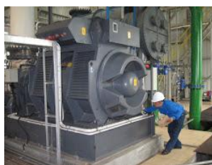
Gambar 18. Memeriksa Instalasi Generator
