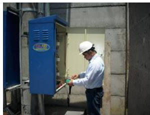
Gambar 11. Memeriksa dan Menguji Instalasi Distribusi Tenaga Listrik
