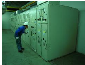
Gambar 16. Memeriksa dan Menguji Performance Switchgear
