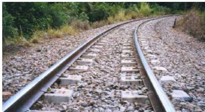
Figura 15 - Dormente bi-bloco
