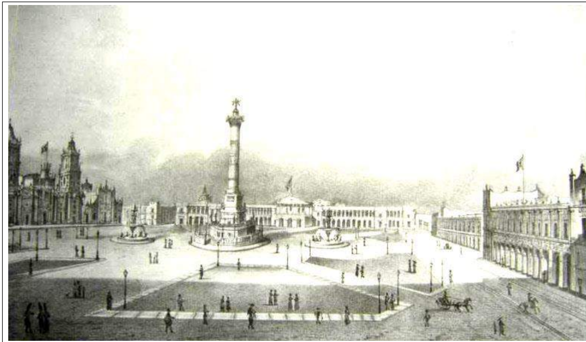
C3-12 Litografía de Pedro Gualdi, 1843, mapoteca Manuel Orozco y Berra, SAGARPA. Posiblemente el mismo Gualdi sea el autor y la única diferencia notable es que el Palacio Nacional modifica su fachada principal, construyéndose un pórtico nuevo. A este proyecto se le denominó Plaza Nueva de la Independencia, mismo que nunca fue concluido. Esta imagen formó parte del Álbum Fotográfico México Artístico y Pintoresco publicado en 1849 por don Julio A. Michaud.
