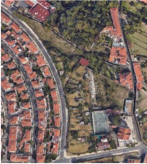
Fig. 44: Situação actual da Rua Marquês de Olhão
