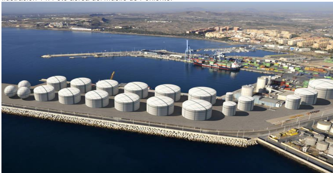
Ilustración 14: Foto aérea del Muelle de Poniente.
