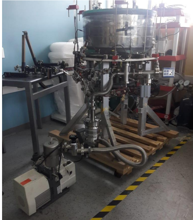
Figura 5. Montaje del sistema de vacío del Tokamak Esférico MEDUSA-CR.
