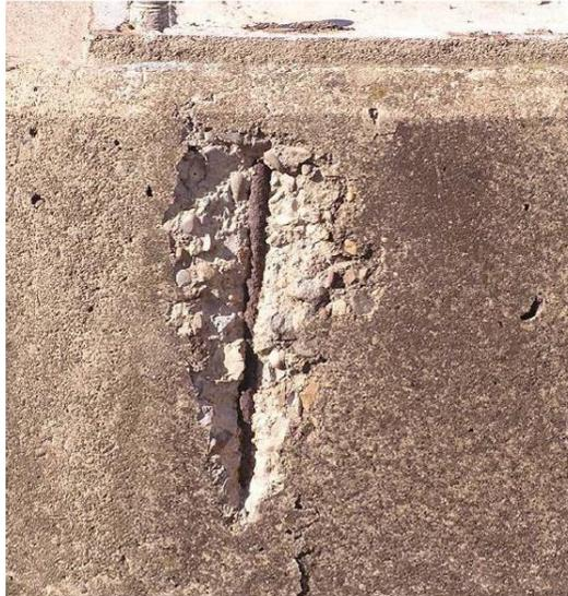
Figura 6.3. Carbonatación del concreto y consecuente descamado.
