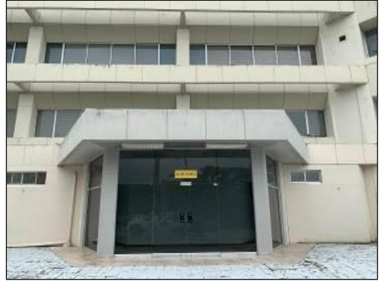
Auditorio en la parte posterior del edificio rectorado.
