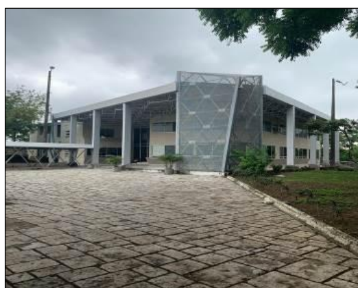
Plazoleta posterior y punto de encuentro 2 del edificio rectorado.
