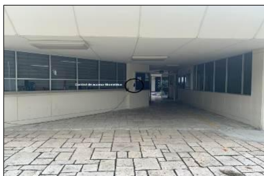
Entrada y salida secundaria edificio rectorado.
