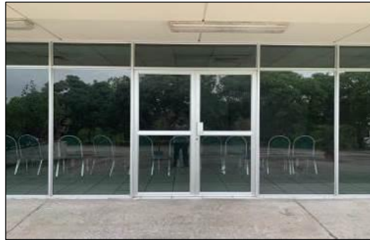
Salida secundaria del auditorio del edificio rectorado.
