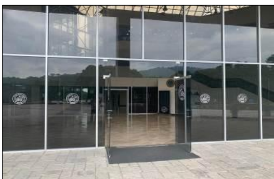
Entrada y salida principal edificio rectorado.
