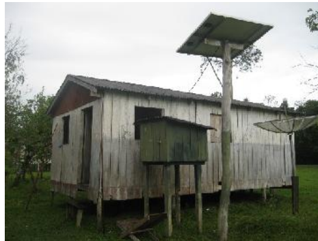
Figura 11: Sistema Fotovoltaico Aislado
