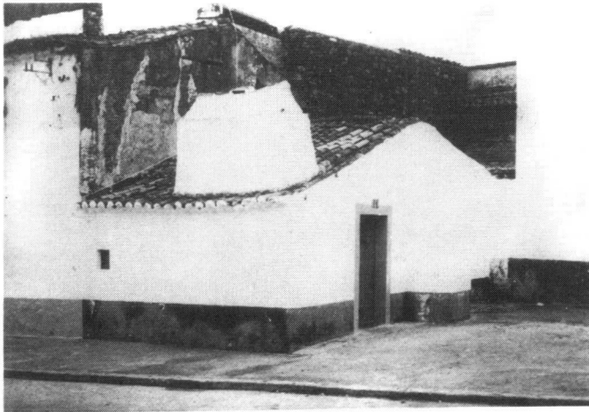
Chimenea de gran cuerpo sobre pequeña vivienda. Olivenza.
