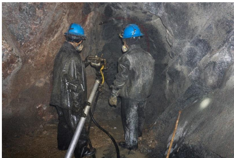
Figura 14. Perforación de taladros con perforadora neumático tipo Jackleg- Mina San Luis.
