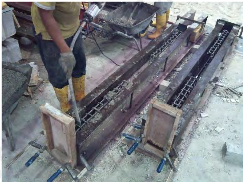
(d) Concrete casting and compaction process
