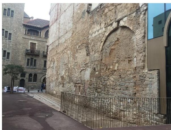
Fig. 4.26,4.27. Plaça del Vuit de Març con el acueducto romano de fondo. Enero 2017. Fotos: Ana Pastor.
