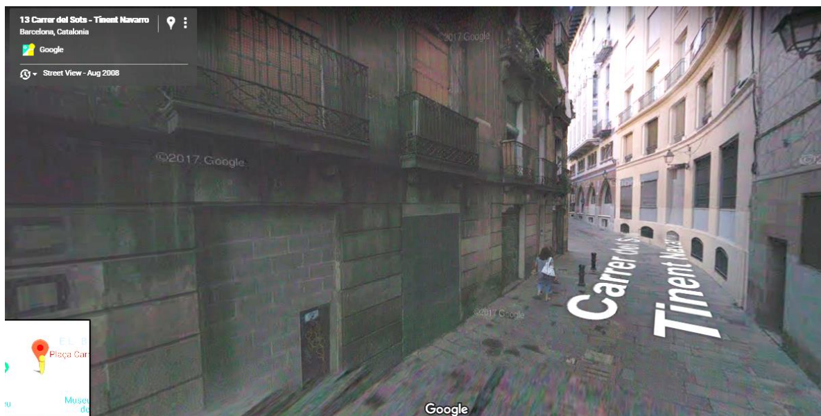
Fig.5.87. Captura de Google Maps de agosto del año 2008 antes del derribo de los dos edificios que aparecen a la izquierda; uno de ellos con las ventanas tapiadas.
