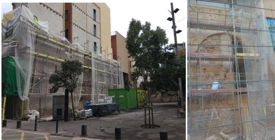
Figs. 5.81. 5.82. Obras del acueducto de la Plaça del Vuit de Març. Enero (izq.) y marzo (dcha.) de 2019. Fotos: Ana Pastor.
