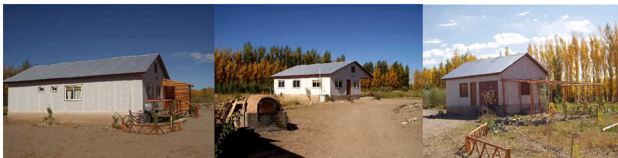
Figura 1: Edificios que conforman el conjunto del hostelling internacional.
