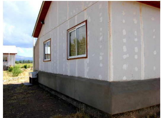
Figura 10: foto de la incorporación de aislación térmica al basamento
