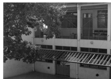
Fig. 2: Vista exterior galería con parasol
