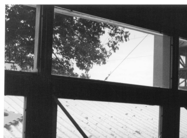
Fig. 4: Interior comedor con galería y estantes de luz
