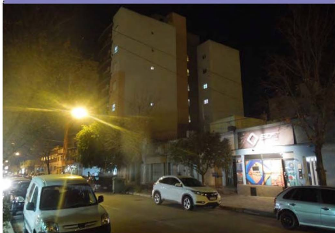
Figura 71. Discontinuidad en la altura de la edificación
