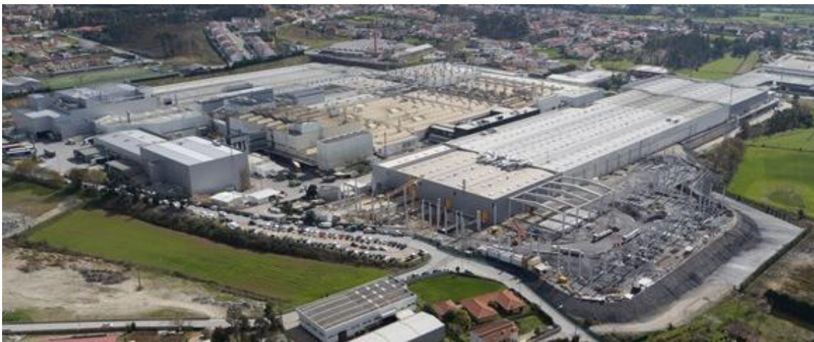
Figura 14. Instalações da Continental Mabor (Neves, 2019)
