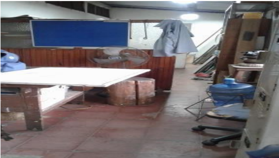
Imagen 6: Se observa acumulación de objetos que pueden ser peligrosos para la salud del trabajador.
