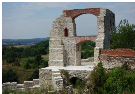
Ryc. 1 Zamek Tenczyn. Ceglany łuk stabilizujący zagrożony filar. Efekt prac Z. Hendla z 1912 r. Fot. autor, 2005 r.
