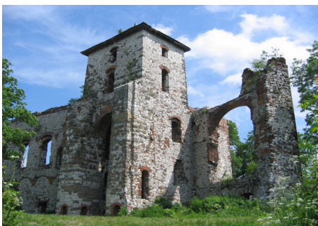
Ryc. 1 Zamek Tenczyn. Ceglany łuk stabilizujący zagrożony filar. Efekt prac Z. Hendla z 1912 r. Fot. autor, 2005 r.
