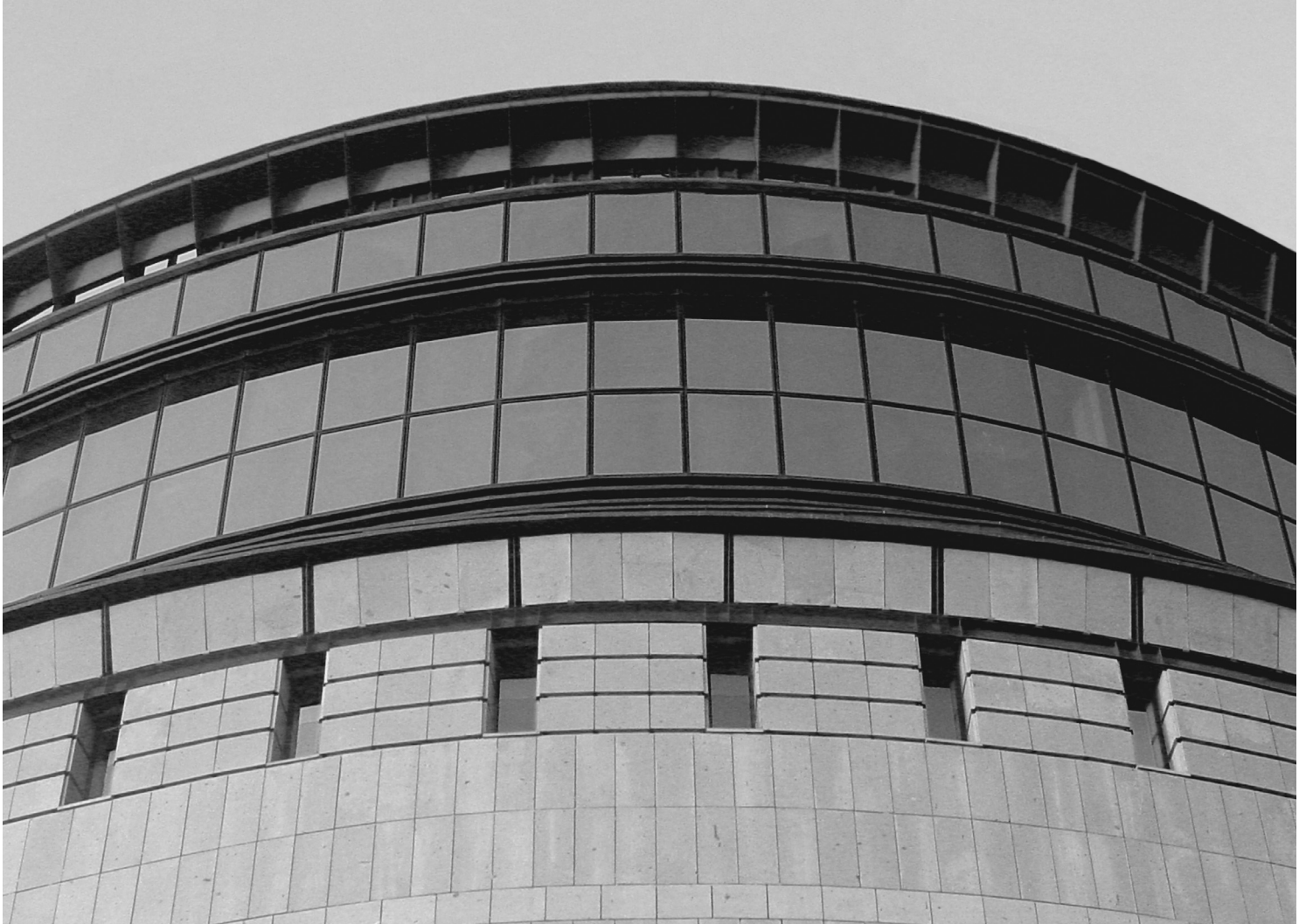
Ил. бр. 13. Коришћење елемената челичних профила призива естетски кредо модернизма, где је једноставна линија I профила постала својеврстан елемент декорације. Акценти изведени у челику придају машински карактер прилагођени су једноставној технологији градње у оплемењивању архитектонског језика. Пословни објекат МПС у Београду , аутор архитекта Бранислав Митровић, 1997. Фотографија из архиве аутора.
