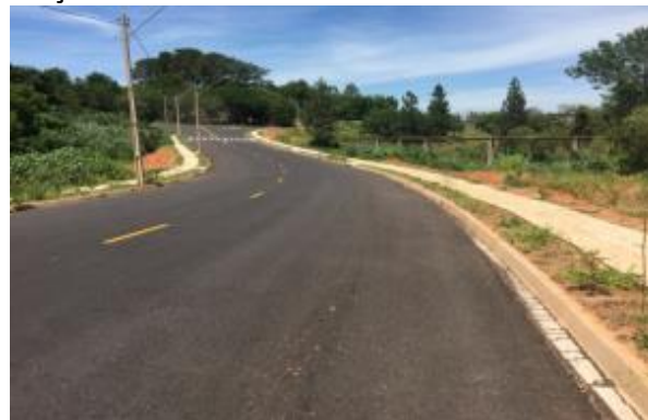
Figura 13. Intervenção em área de APP- construção de vias.
