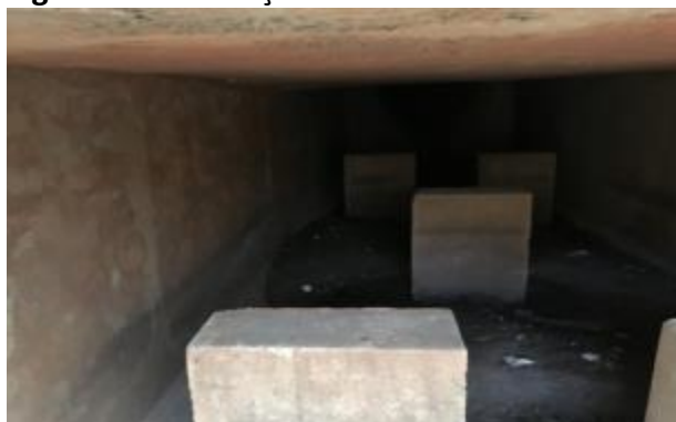
Figura 9. Canalização da nascente
