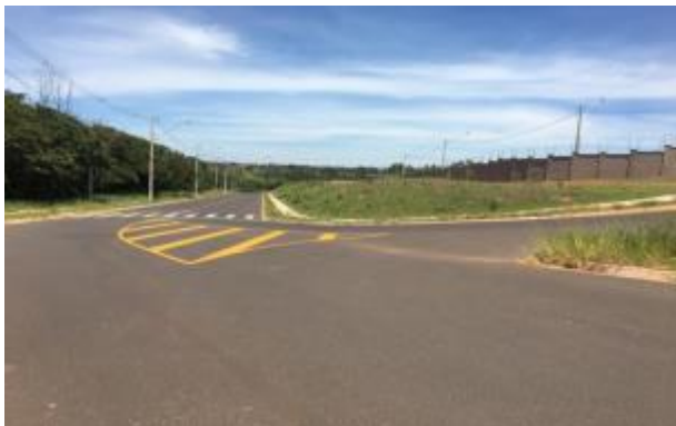
Figura 12. Construção do condomínio próximo à área de APP.
