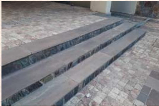
Revestimiento en alzada de los escalones en combinación con otros tipos de lajas
