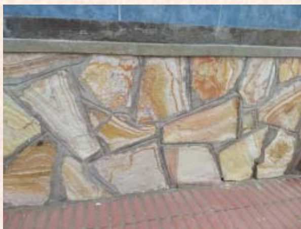
Revestimiento de fachada
