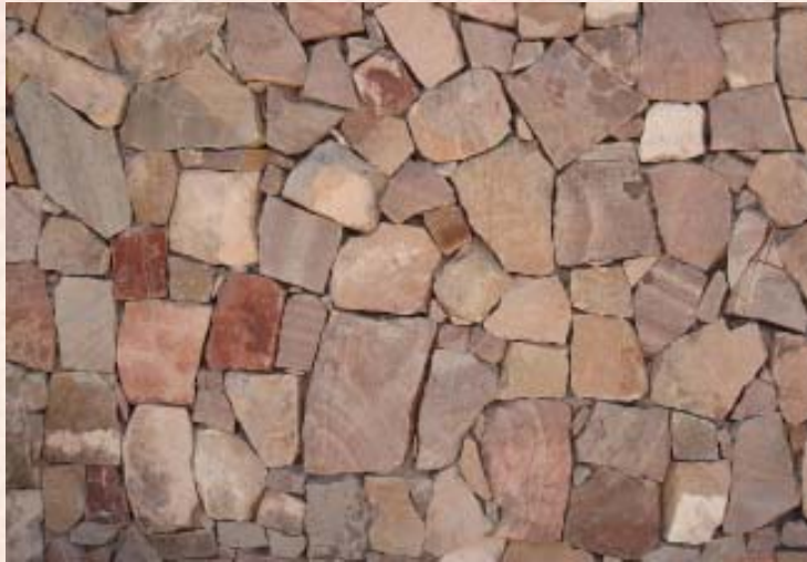
Detalle de paredón en vivienda
