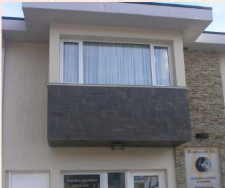
Revestimiento de un balcón con lajas cortadas y muretes
