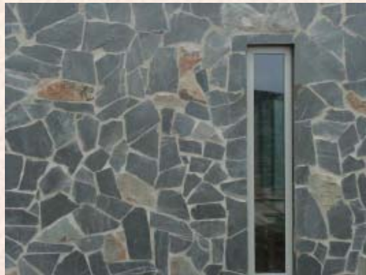
Revestimiento de fachada
