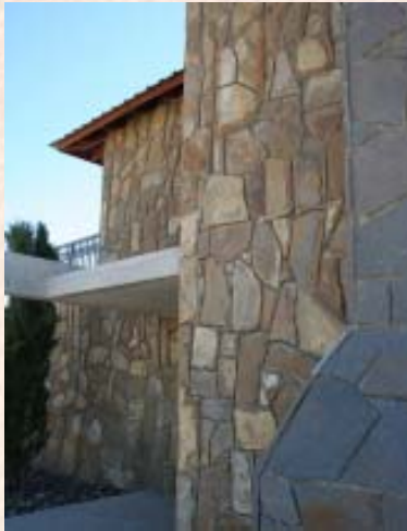
Detalle colocación en frente de vivienda
