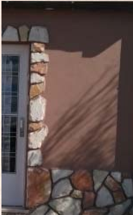
Fachada en vivienda
