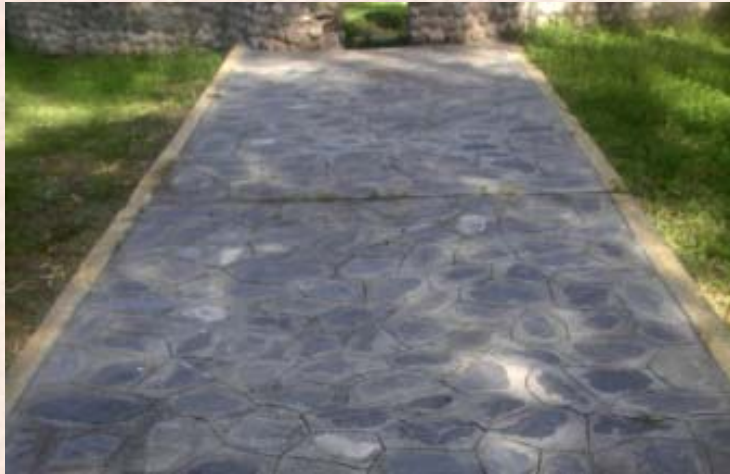
Vereda de acceso a la Iglesia de San Pedro, departamento Capayán, Catamarca
