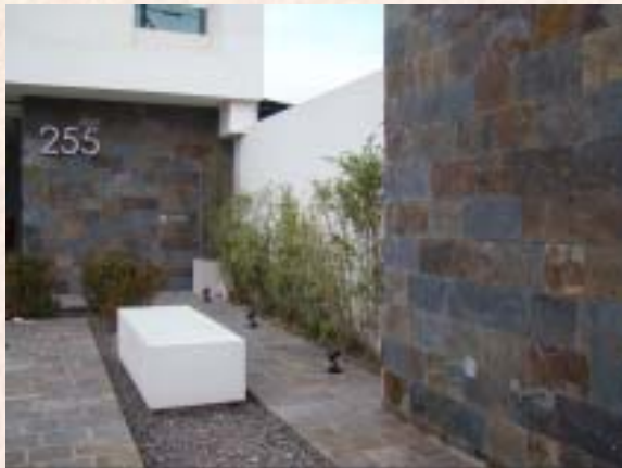
Lajas cortadas y colocadas como revestimiento
