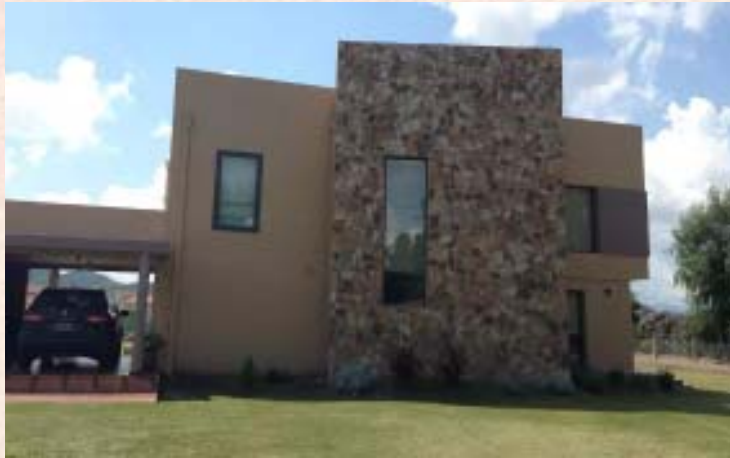
Muro en vivienda unifamiliar
