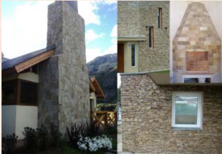
Colocación del material como revestimientos
