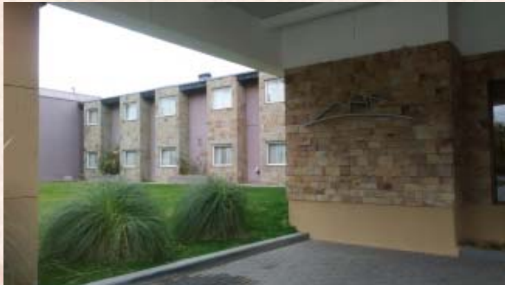
Paredes externas del Hotel Malargüe Inn & Suites
