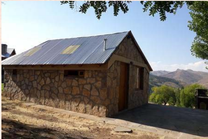
Revestimiento externo en construcción civil de Las Ovejas
