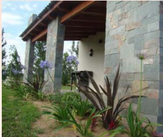
Revestimiento de muros en vivienda unifamiliar
