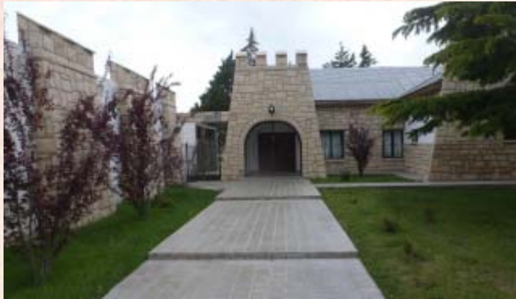
Fachada del frente del Club Banco Provincia de Neuquén en Zapala
