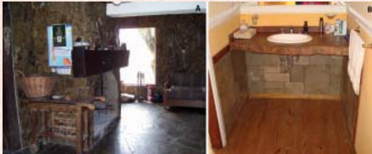
Colocación de la piedra laja como revestimiento de interiores (piso, paredes, otros)
