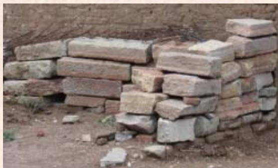
Acopio de cordones
