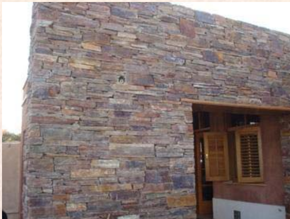
Muretes en paredes
