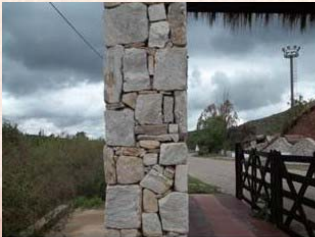
Revestimiento de columna
