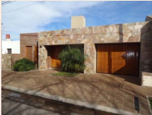
Revestimiento de fachada en vivienda unifamiliar
