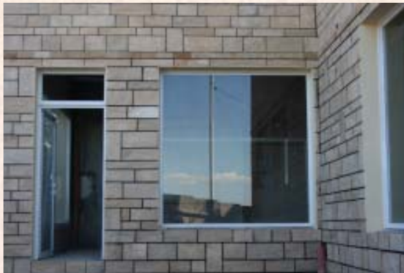
Fachada con piezas largo libre y junta coloreada
