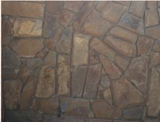
Colocación en frente de vivienda
