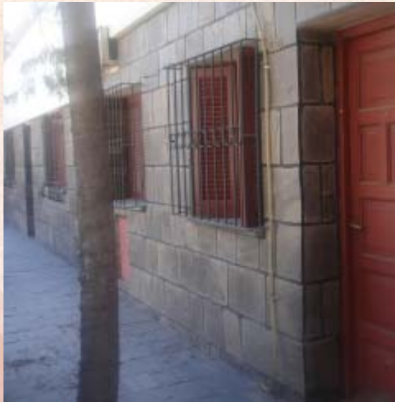
Colocación en fachadas de viviendas de la ciudad de San Fernando del Valle de Catamarca
