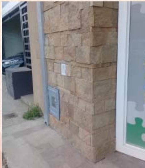
Revestimiento de fachadas
