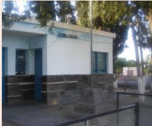
Colocación en fachada de vivienda
