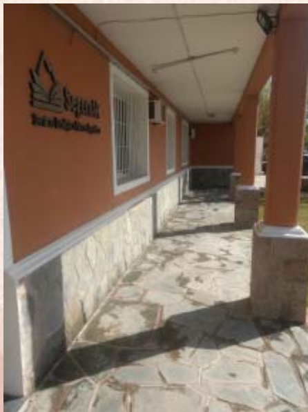
Aplicaciones en piso y fachada en el Centro Regional SEGEMAR de La Rioja
