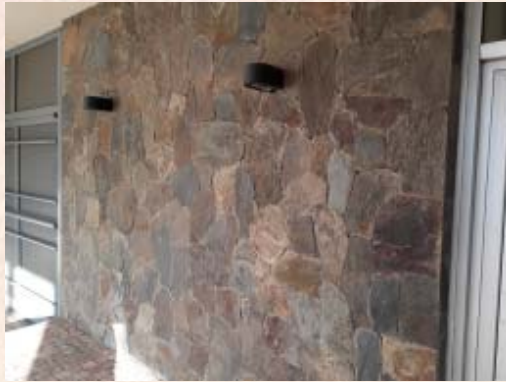
Revestimiento en pared, muretes con junta cerrada
