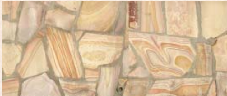
Detalle del muro revestido
