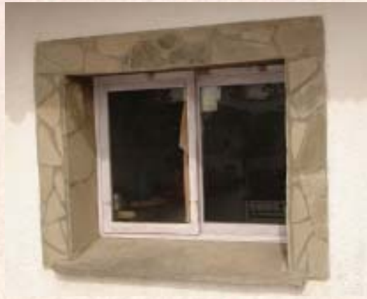
Revestimiento del perímetro de una ventana
