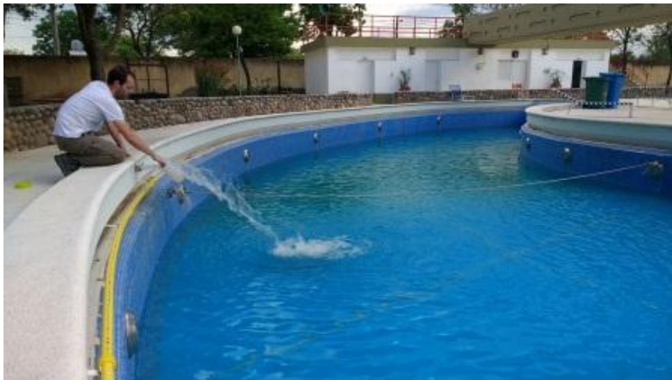
Figura 8.16. Pileta de grandes dimensiones en complejo hotelero de Luz y Fuerza.
