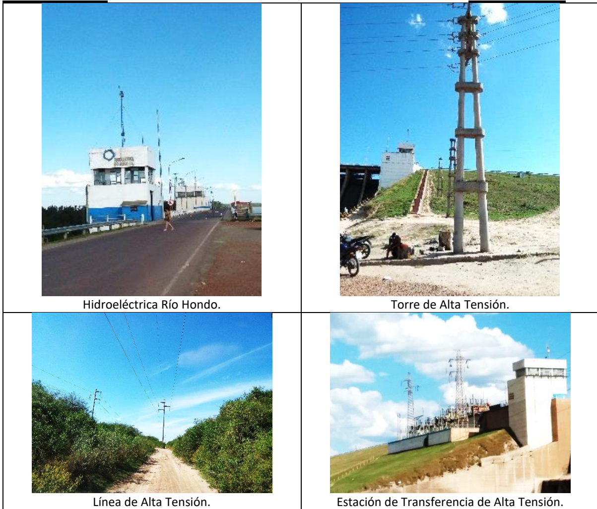
Figura 10.5. Central energética y plantas de transferencia.
