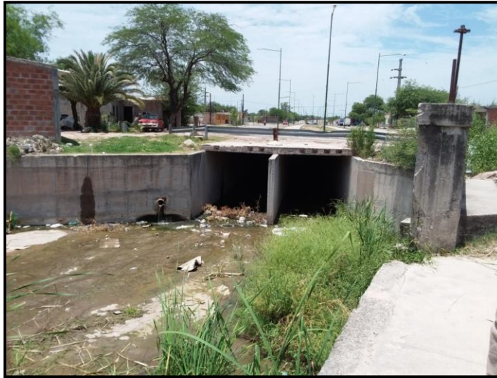
Figura 4.5. Inicio del entubamiento del Aº Chujchala al ingresar a la ciudad.
