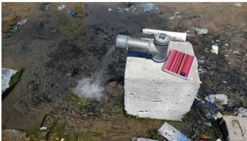
Figura 8.15. Perforación surgente abierta.
