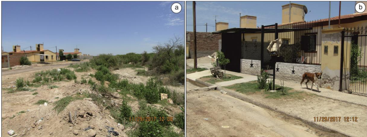
Figura 11.2. a. Ubicación de las casas del barrio Galeano con respecto al cauce del arroyo Chujchala. b. Foto en donde se observa la altura a la que llegó el agua de desborde indicada por las flechas.
