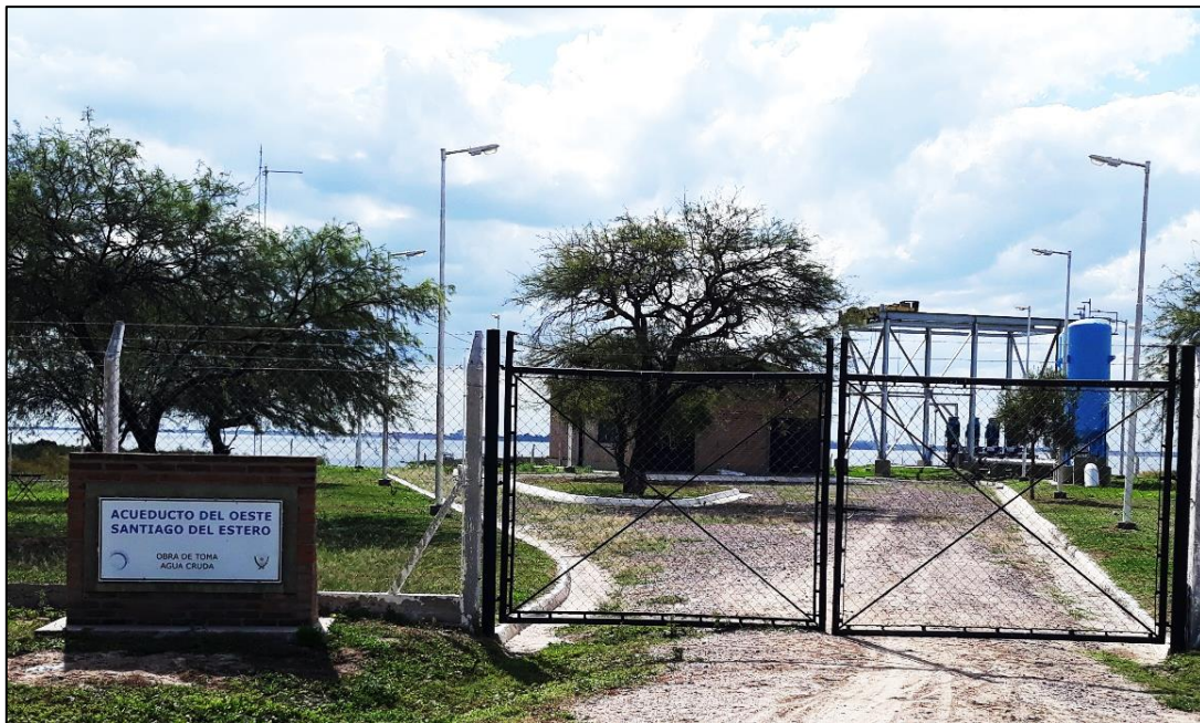
Figura 10.9. Acueducto del Oeste, Santiago del Estero. Toma de agua cruda.
