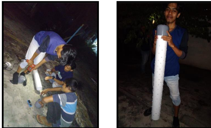
Gambar 3. Teknik Pembuatan Tabung Biopori
