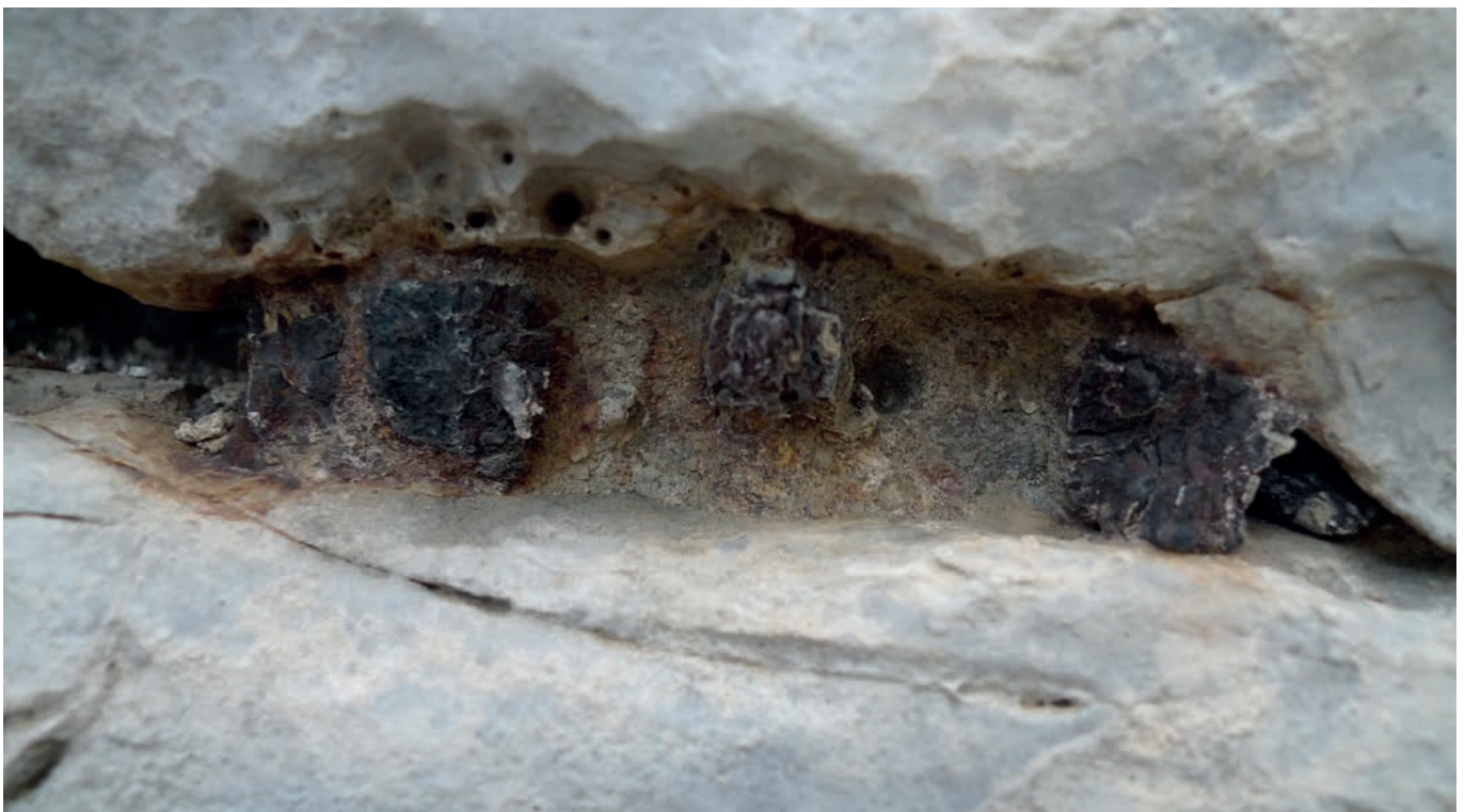
Fig. 8: Particolare di alcuni elementi metallici tra due pietre, circondati da malta aggiunta dopo il loro inserimento
