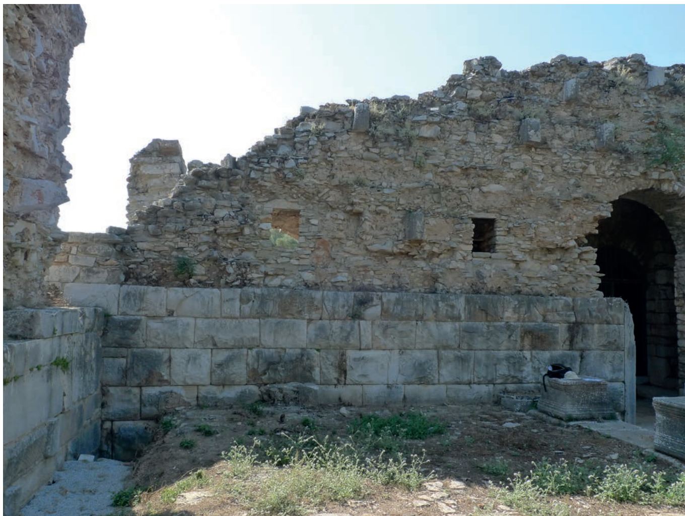
Fig. 13: Prospetto Ovest del Bouleuterion. Nella parte in cui blocchi in opera quadrata del paramento sono stati asportati si distinguono blocchi di testa destinati ad accrescere l’ammorsatura tra nucleo e paramento e l’altezza dei getti di conglomerato, corrispondente con l’altezza dei blocchi del paramento.
