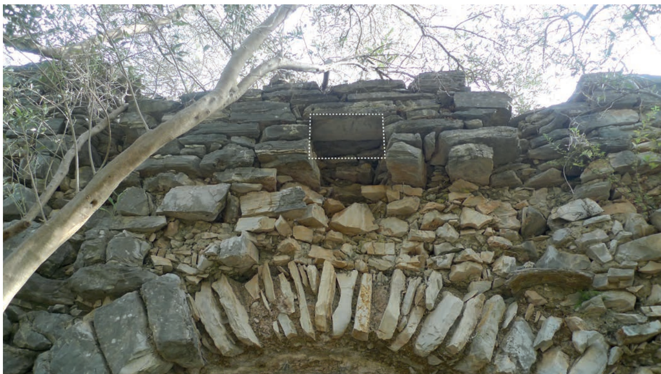
Fig. 7: Veduta dal basso della parte centrale della nicchia, dove appare evidente la differenza tra la dimensione dei blocchi dell'arco di facciata e delle pietre che formano il catino della nicchia. In tratteggio la sede di una delle travi che sorreggevano la centina della volta.
