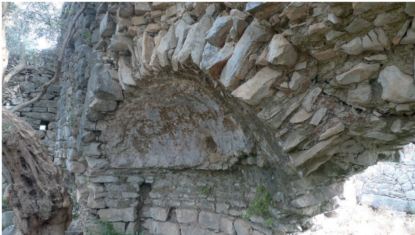
Fig. 6: Veduta di scorcio della tessitura della volta della calotta della nicchia.
