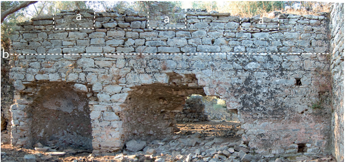
Fig. 16: Veduta della contro-parete del muro Nord dell'ambiente C (muro Sud dell'ambiente F ). La grande lacuna al centro corrisponde alla nicchia al centro della parete di (C). a) finestre successivamente tamponate; b) imposta della volta a botte di (F). Si noti la differente dimensione delle pietre di (F) rispetto a quelle di (C).
