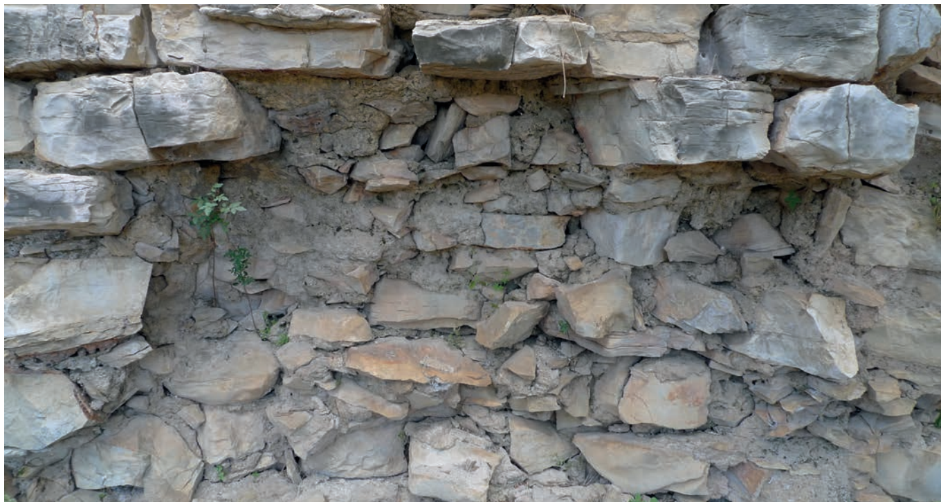
Fig. 10: Particolare del nucleo della parete Nord dell'ambiente (C).
