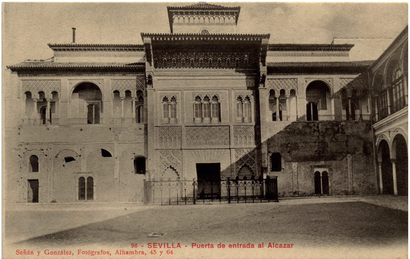
Figura 9. Fachada principal del palacio de Pedro I. Fotografía realizada por Rafael Seán y González. Colección particular de Alfonso Jiménez.
