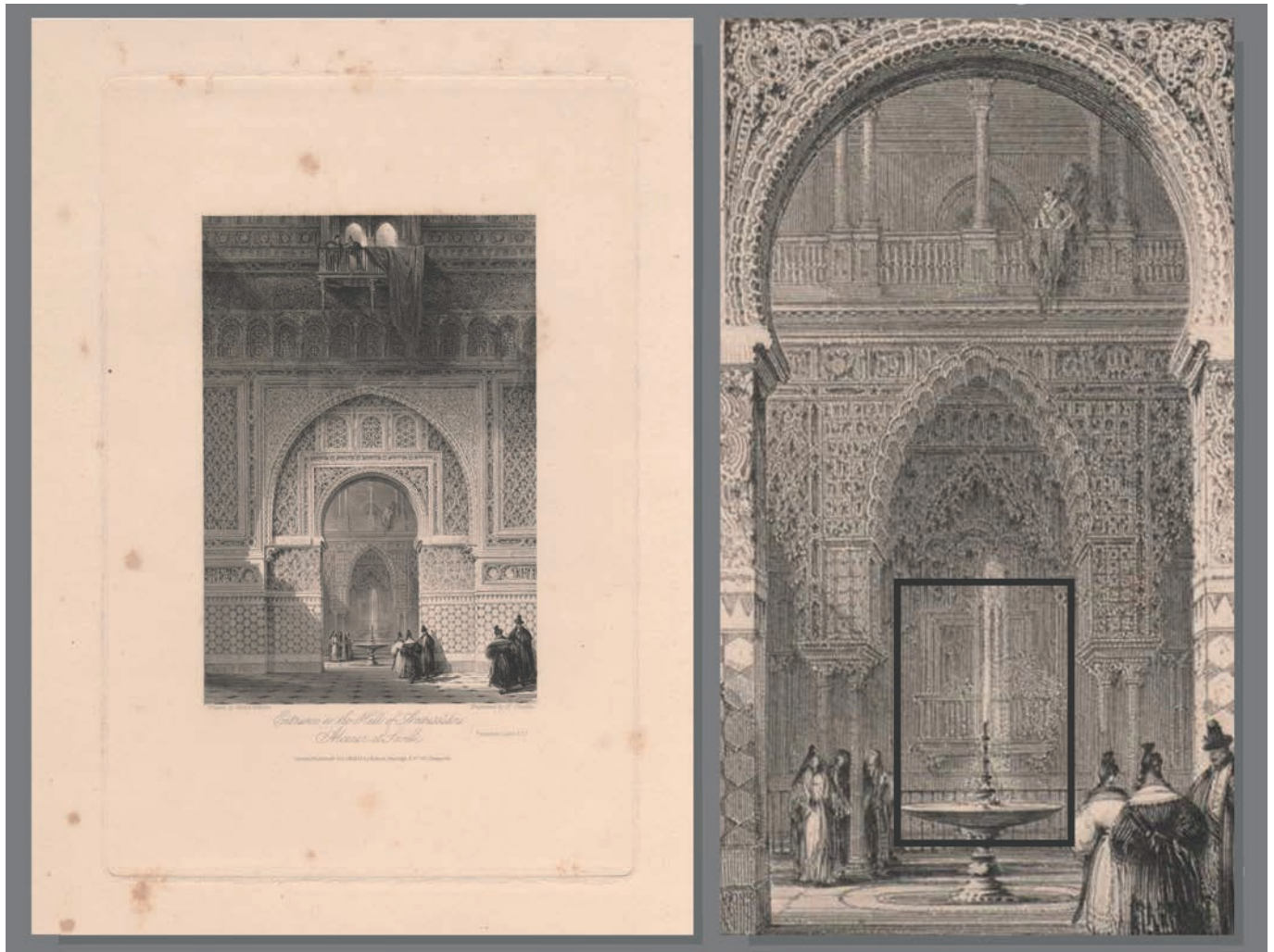
Figura 17. Vista desde el Salón de Embajadores hacia el muro oriental del Patio de las Doncellas con la ventana hacia el Palacio Gótico.
