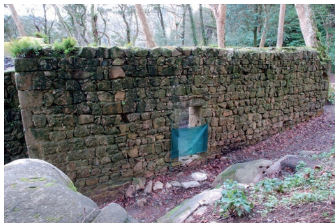
Figura 17. Alzado exterior del muro norte de la iglesia de S. Pedro de Canaferrim.
