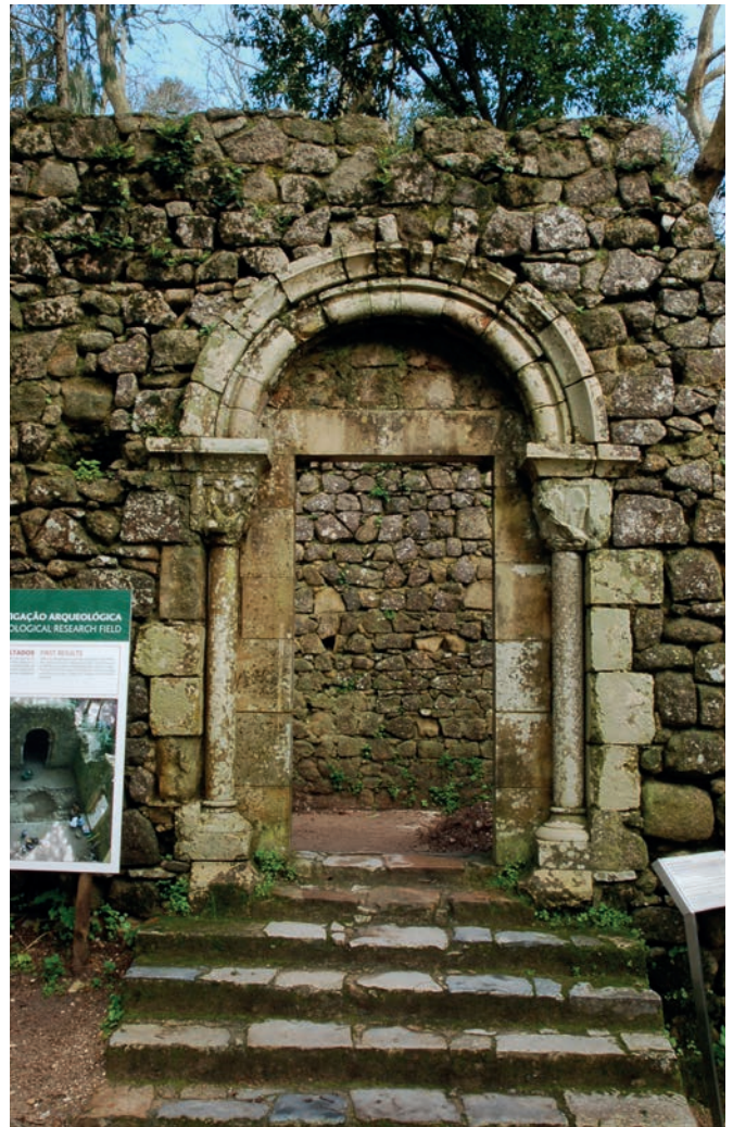
Figura 9. Portal sur de la iglesia restaurado (Etapa VII).
