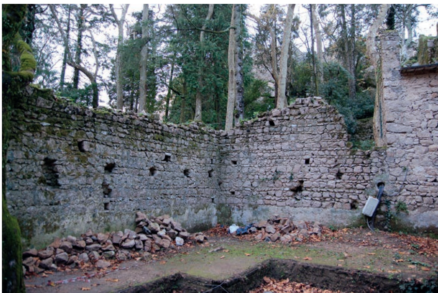
Figura 23. Muros oeste y norte en la estancia norte (UE 1211), adosada al interior del lienzo este.
