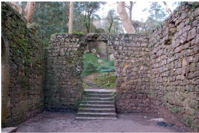
Figura 19. Acceso oeste al interior de la nave de la iglesia de S. Pedro de Canaferrim.
