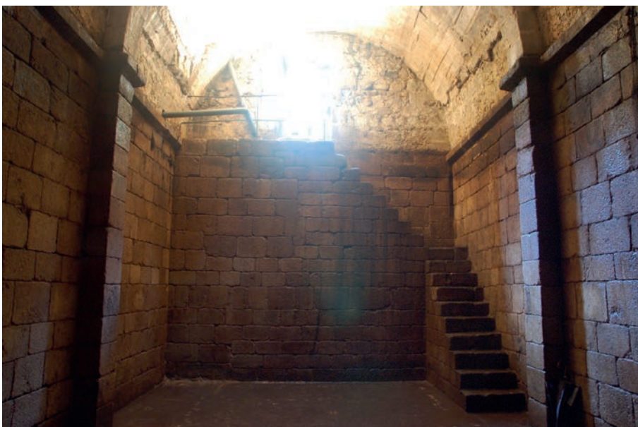
Figura 22. Escaleras de sillería reutilizada en el acceso a la cisterna del castelo.
