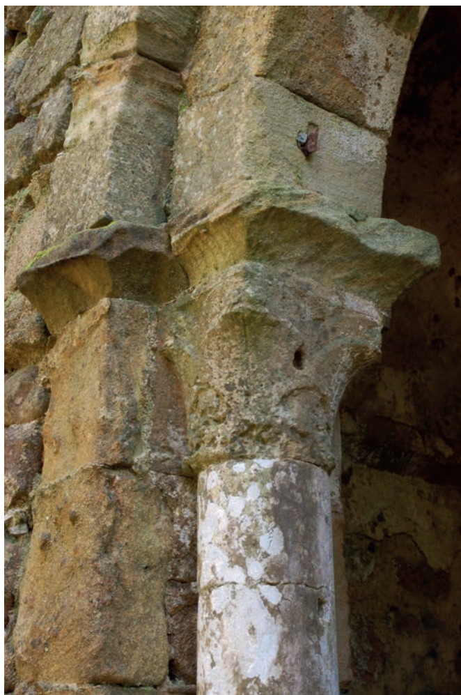
Figura 10. Arco de embocadura del ábside de la iglesia. Capitel norte.
