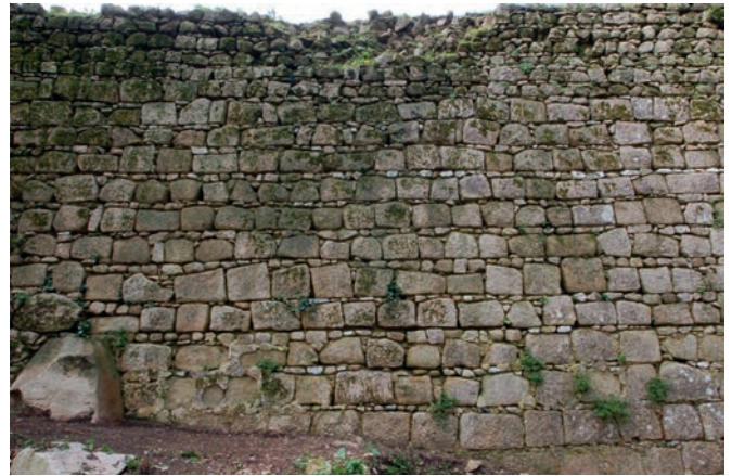
Figura 5. Paño 2/3 del lienzo oriental con restos del encintado de las juntas en la parte inferior.
