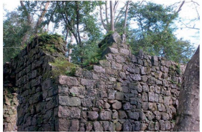
Figura 33. Ruina romántica en la esquina suroeste de la iglesia de Canaferrim.
