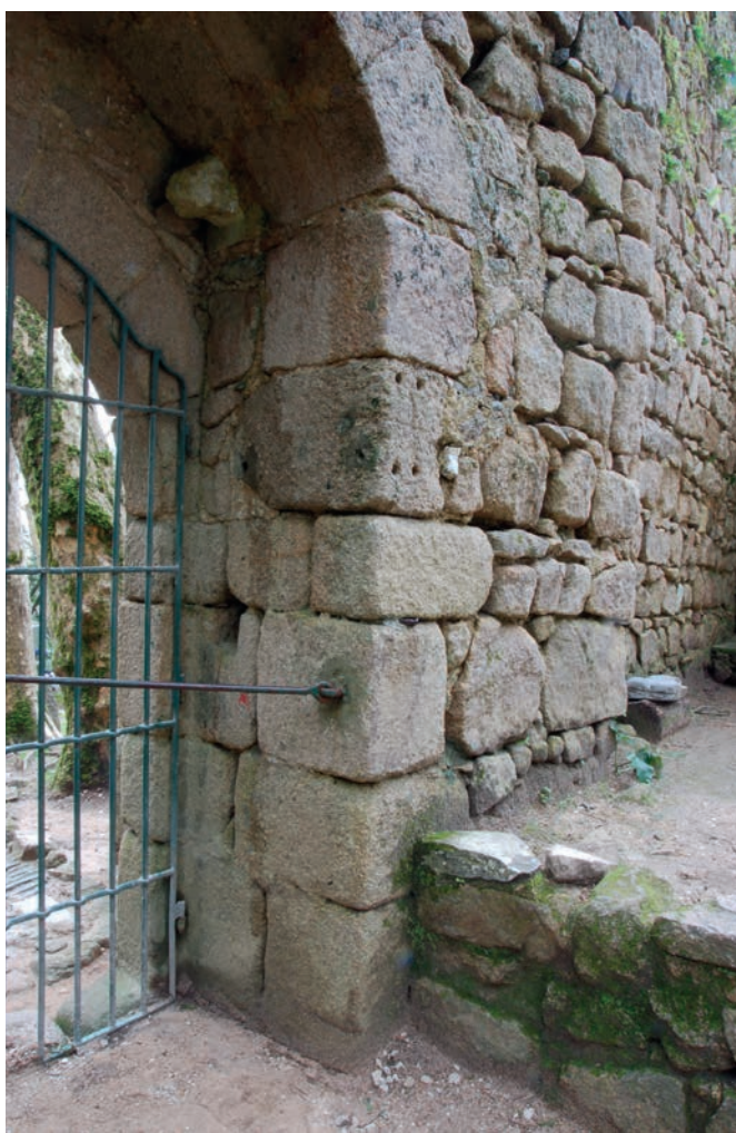
Figura 15. Jamba sur de la puerta principal del castelo al interior, con gorronea de material y talla diferente.
