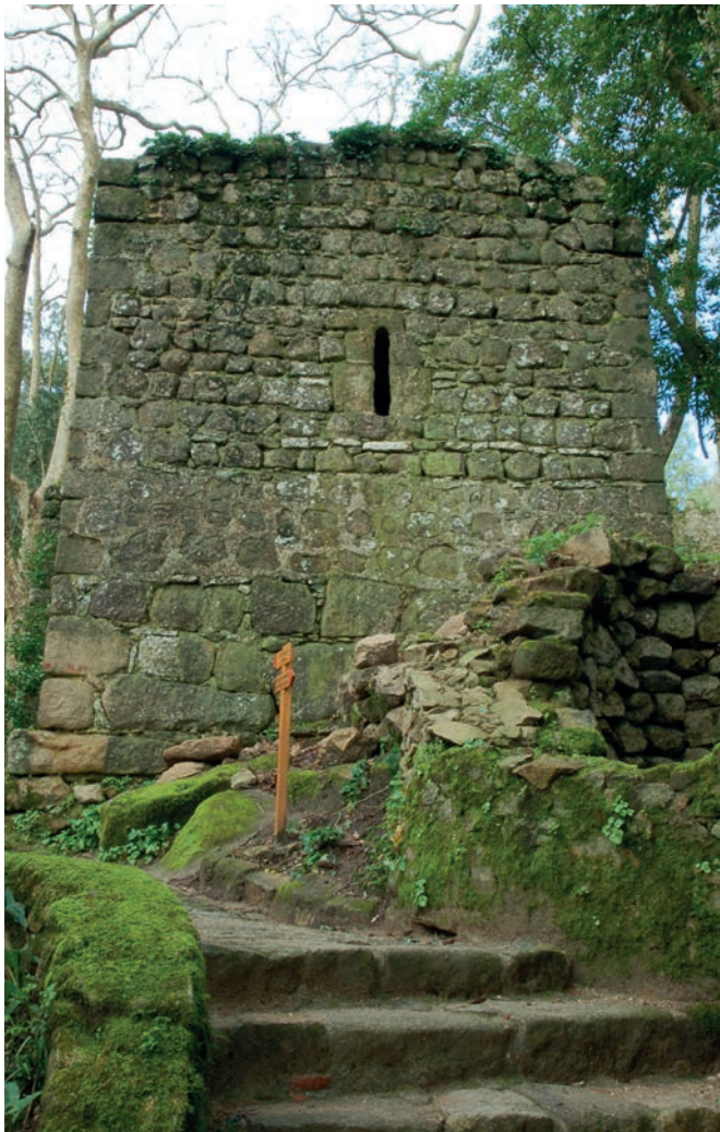
Figura 8. Testero del ábside de la iglesia de S. Pedro de Canaferrim.
