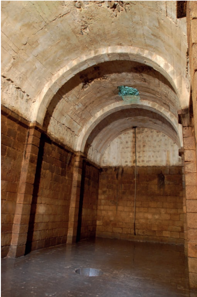
Figura 21. Cisterna del castelo con la bóveda reconstruida (Etapa VI).
