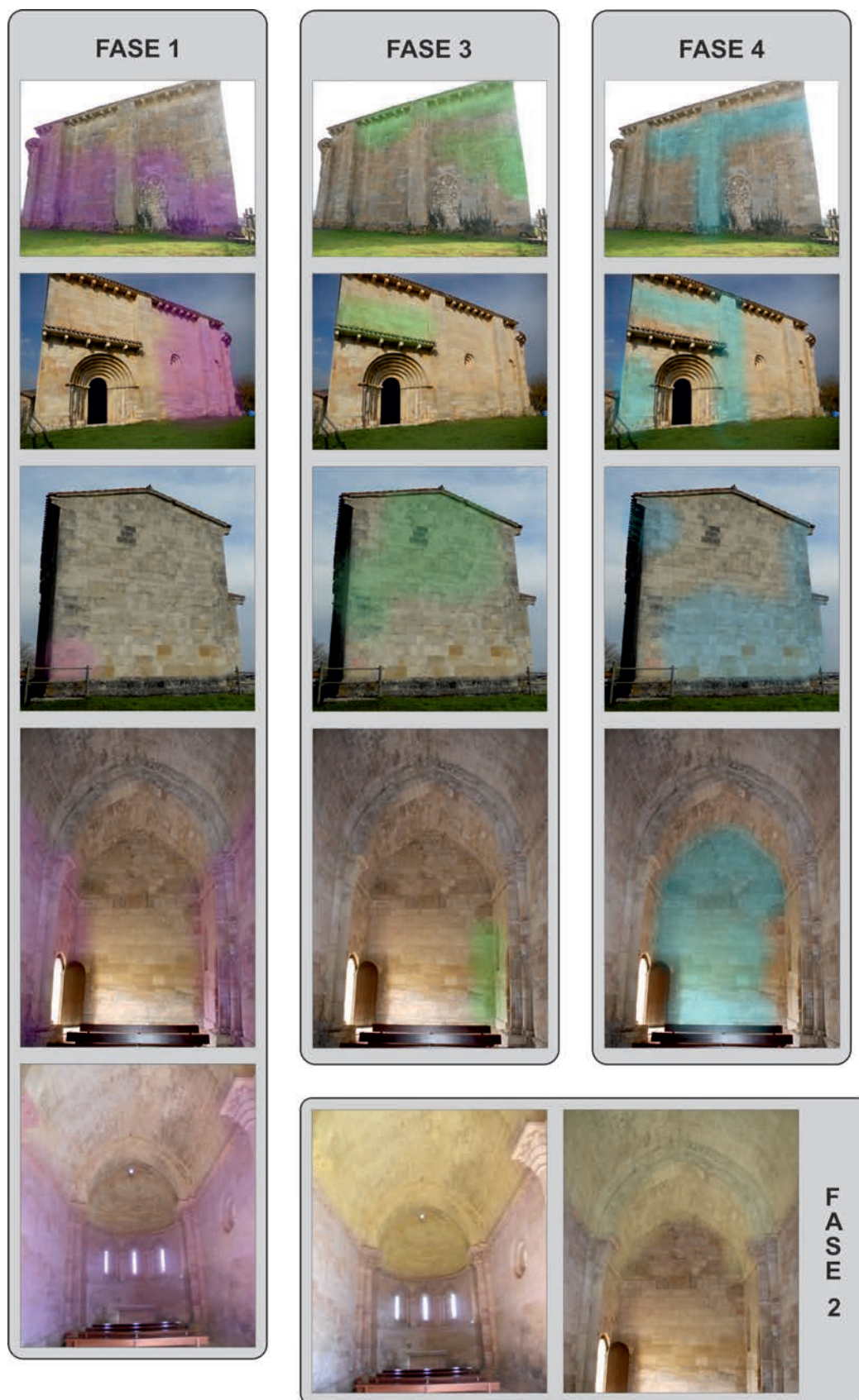
Figura 6. Esbozo a grandes trazos de la evolución histórico-constructiva de San Vicentejo, realizada a partir de la localización sobre los alzados de los 4 clústeres más significativos.
