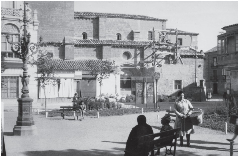
Fig. 16. Proceso de desmonte de la estancia adosada al sur de la iglesia (Diciembre 1931-1932, IPHE)
