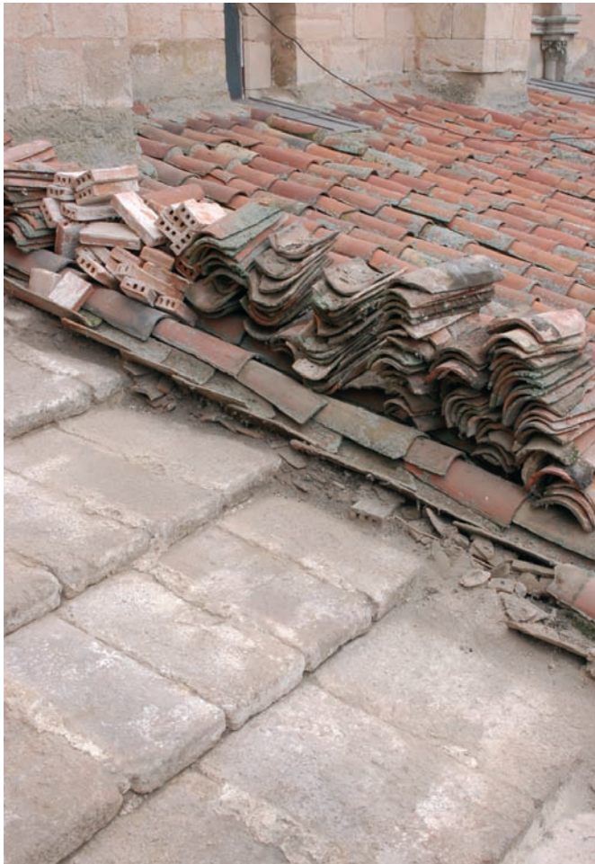
Fig. 14. Cubierta pétrea sobre el tercer tramo de la nave sur de la iglesia
