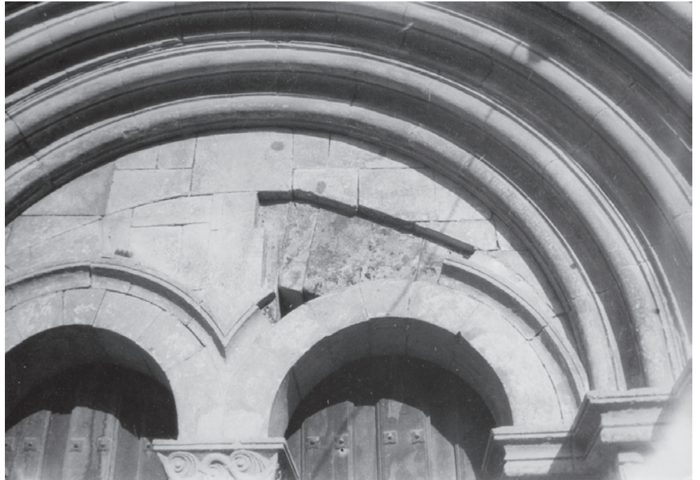
Fig. 10. Detalle del tímpano de la portada sur de la iglesia que permite observar el despiece bajo el aplacado que la cubre (Anterior a 1931, IPHE)
