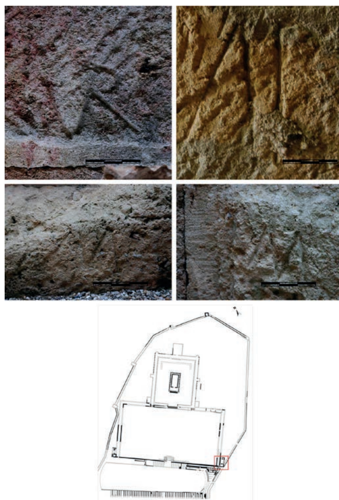
Figura 23. Tarragona, alcuni dei marchi rinvenuti sui paramenti della Torre del Pretorio del Foro Provinciale (M. S. Vinci).
