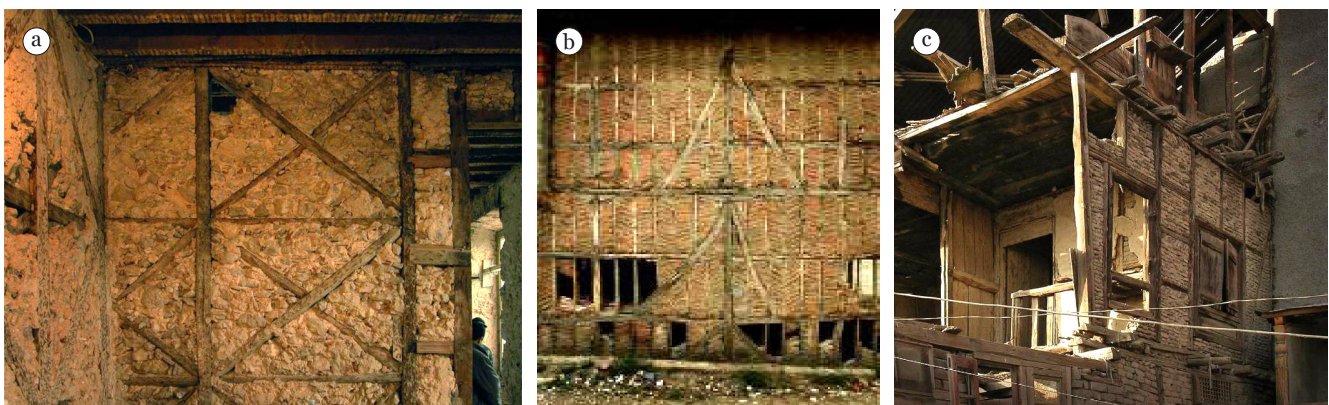
Figura 3. La construcción entramada en otros países: a) Sistema Pombalino (Portugal) (11), b) Himis en Turquía (8), c) dhajji Dewari en Srinagar (8).
