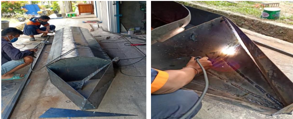
Gambar 5. Proses Pengelasan penuh pada penyambungan Pelat
