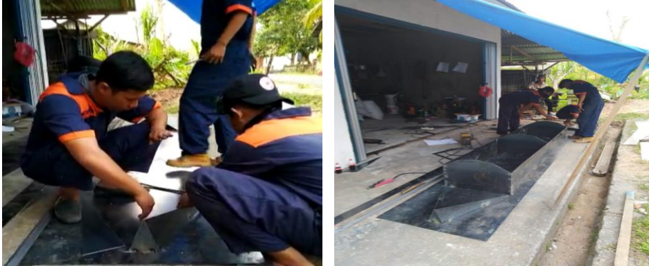
Gambar 4. Proses Penyambungan Pelat
