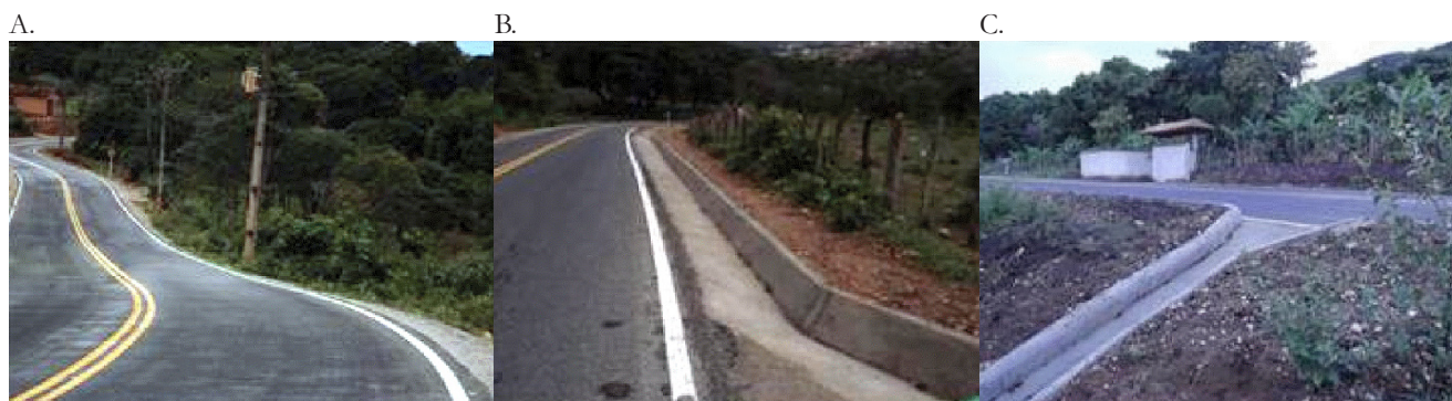
Figura 4. Rodovia estadual baiana que liga os municípios de Senhor do Bonfim a Campo Formoso (A), mostrando detalhe das calhas para drenagem da água pluvial (B, C)
