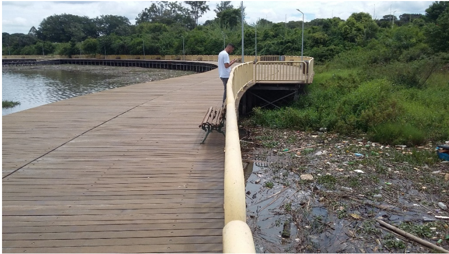
Figura 12. Grande quantidade de resíduos sólidos trazidos pela drenagem lançada junto ao parque Deck SUL.
