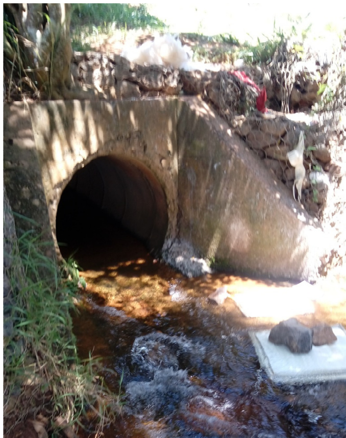
Figura 10. Manilha com lançamento da drenagem pluvial, próximo ao Parque Olhos d'água.
