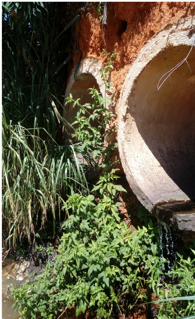
Figura 7. Lançamento de drenagem pluvial ao lado do clube Nipo.
