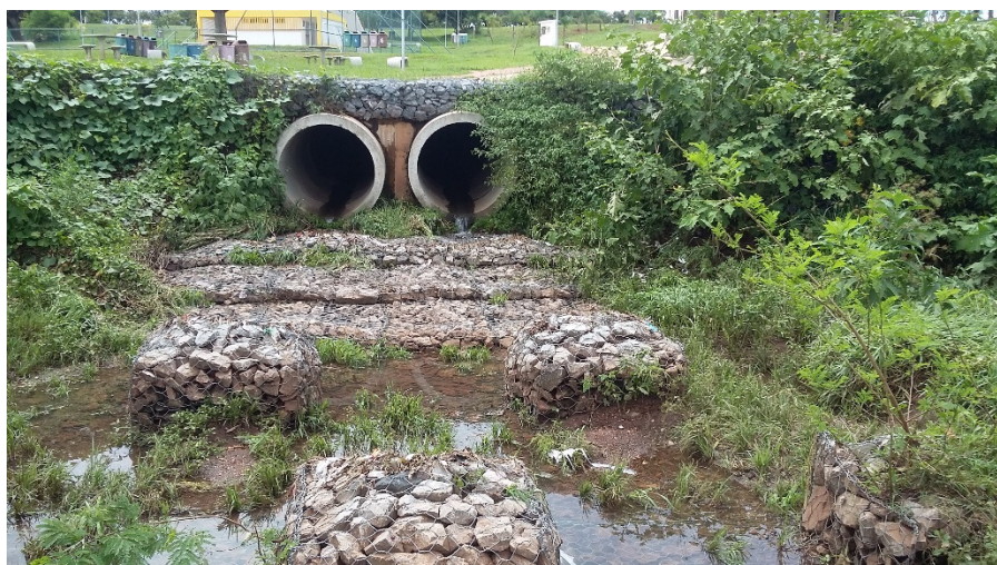
Figura 11. Galerias Deck Sul.
