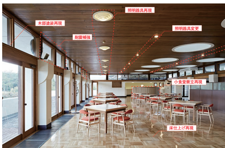
写真15 嵐山カントリークラブ大食堂 改修後
