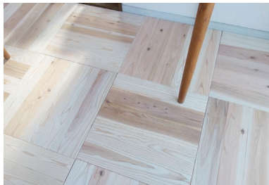
写真23 無垢板をパネル化した床部品
