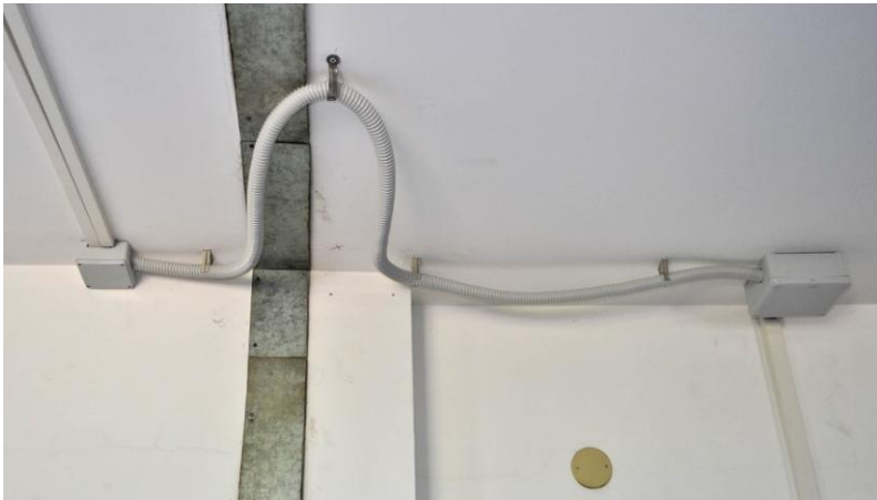
Figura 5.8 - Attraversamento dei cavi in corrispondenza del giunto strutturale.
