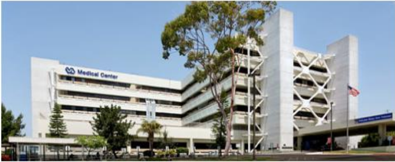
Figura 3.3 – Edificio No.1 San Diego Veterans Affairs Medical Center, California (vista frontale) (Kalkan et al., 2012).
