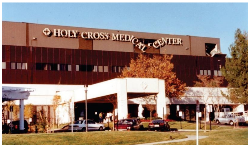
Figura 2.19 - Pannelli di tamponamento danneggiati a causa dell'oscillazione dei componenti HVAC (FEMA, 2012).
