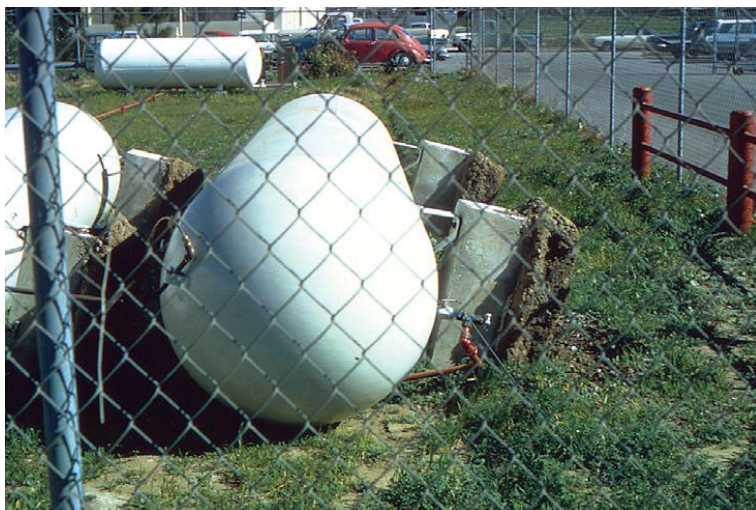
Figura 2.31 - Ribaltamento di serbatoi per lo stoccaggio di carburante (FEMA, 2007).
