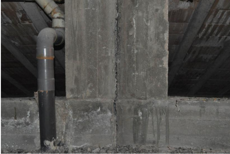
Figura 5.4 - Giunto strutturale tra i blocchi V e VI.
