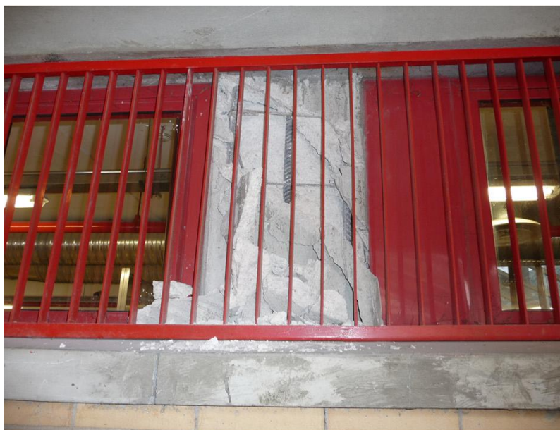
Figura 2.33 - Rottura a taglio di una colonna tozza.
