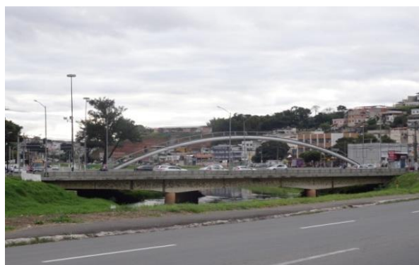
Figura 5: Ponte Pedro Marques.
