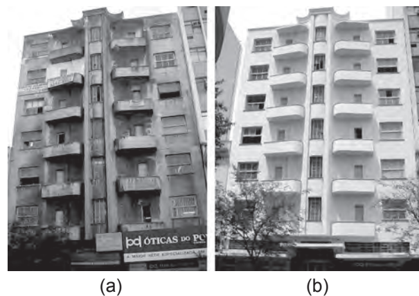
Figura 2: Fachada do Ed. Thibau antes (a) e após (b) as obras de recuperação.
