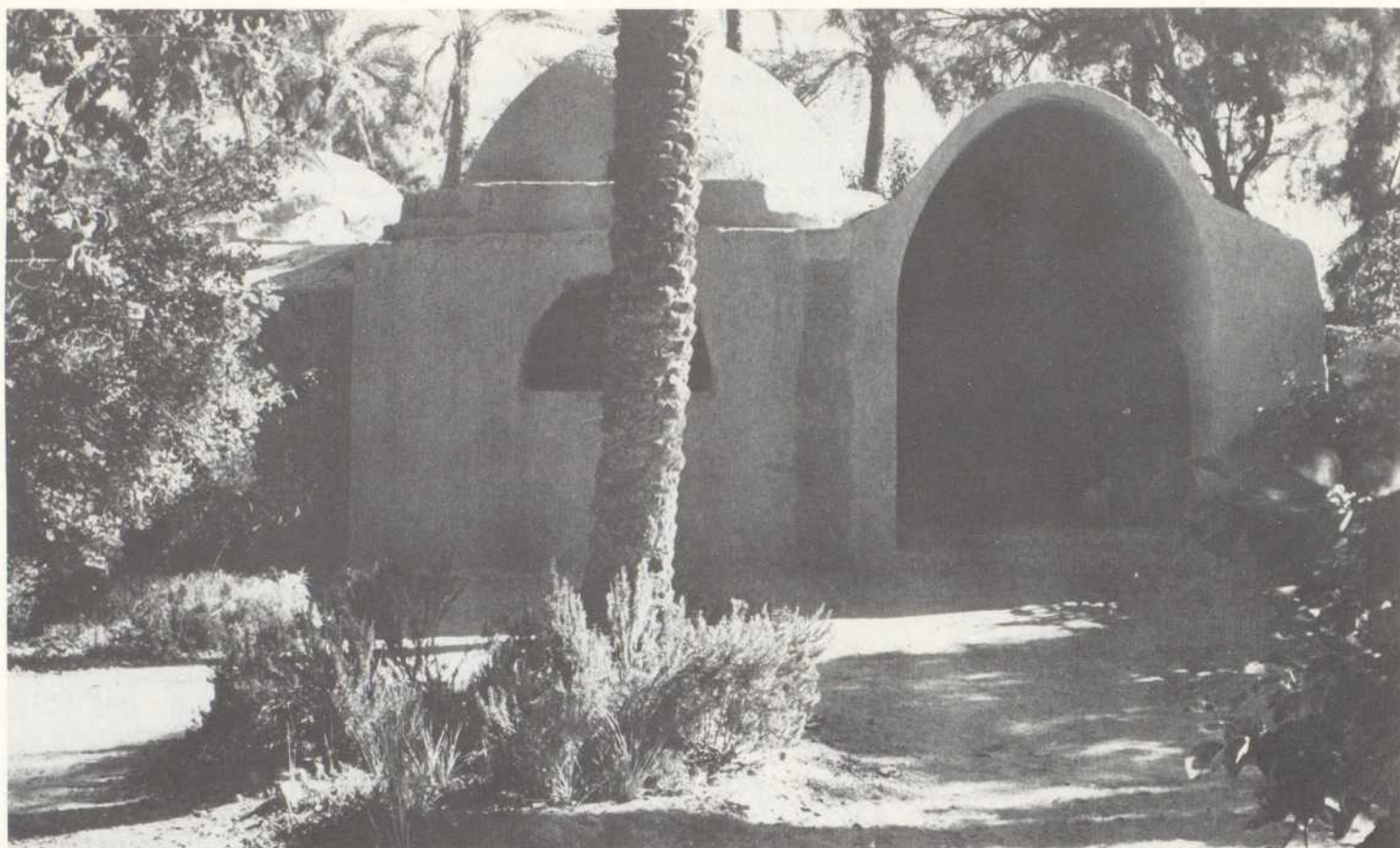
Nordfassade des Hauses Hamed Said. Die Loggia wird als Außenstudio genutzt.
