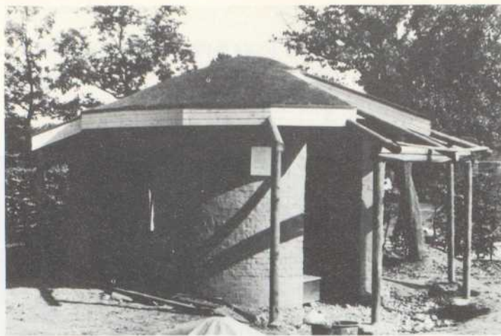
Holzkonstruktion aus Rundholz, An- bau in Fachwerkbauweise; Entwurf: Gundula Richter
