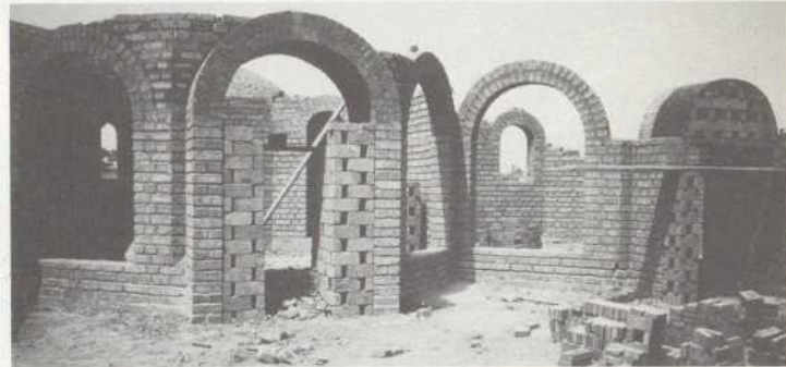
Schalung und Herstellung der Mauerbögen
