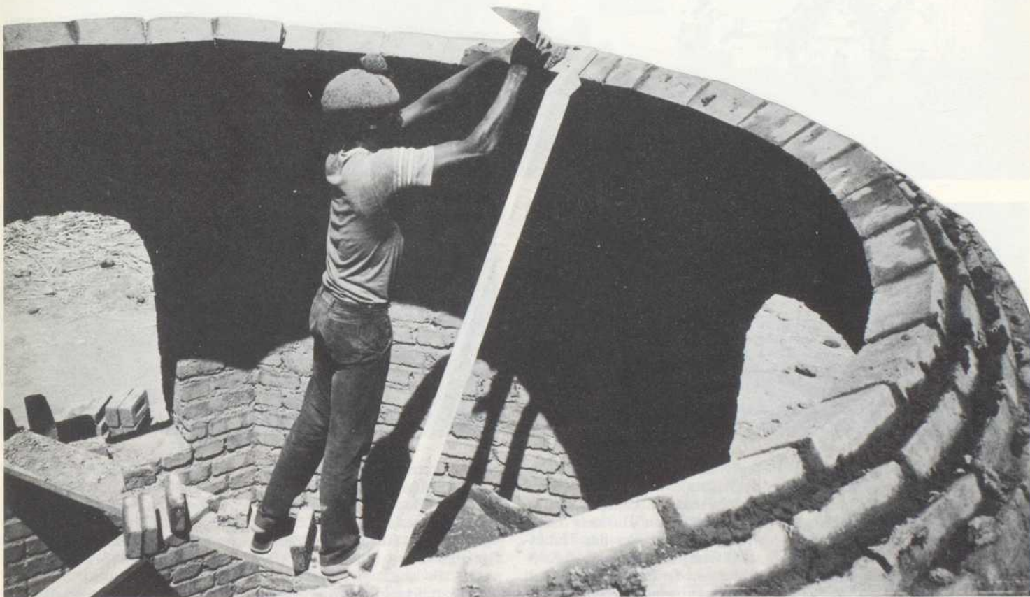
Kuppelbau ohne Schalung
