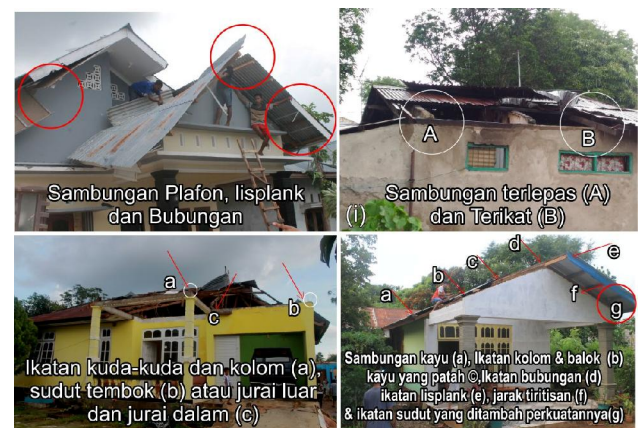
Gambar 9. Sistem konstruksi atap seng pada rumah
