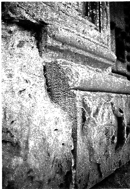
Fig. 4.- Fenómenos de arenización. Fig. 4.- Arenization.
