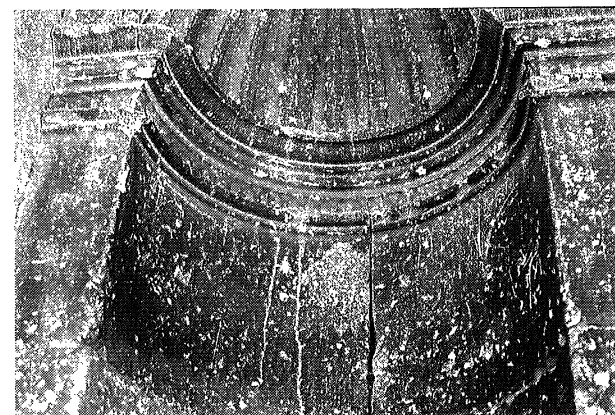
Fig. 5.- Detalle de la costra oscura en la hornacina izquierda. Fig. 5.- Dark crust detail on the left niche.
