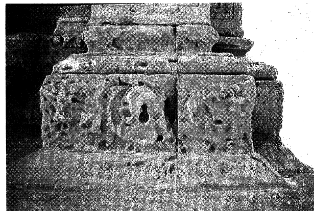
Fig. 3.- Alveolización presente en la parte inferior izquierda de la portada. Fig. 3.- Alveolization on the main door left lower part.
