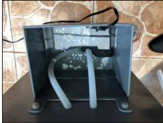
Figura 21-3: Depósito de agua
