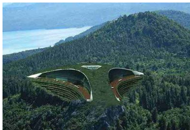
Рис. 9. «Экодружественный» отель сети «Хилтон», «встроенный» в один из холмов на побережье озера, г. Сан-Карлос-де-Барилоче, Аргентина Fig. 9. "Eco Friendly" hotel (network of "Hilton" hotels), built-in in one of the hills on the coast of the lake, San Carlos de Bariloche, Argentina
