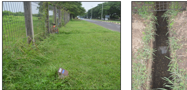
Gambar 2 Area Pelebaran Jalan M1-M2 dan Pipa Pertamina yang ditemukan pada tes pit
