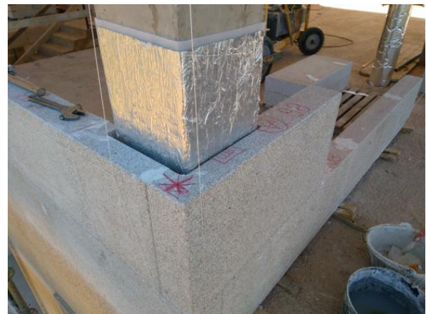
Eliminación de puentes térmicos
