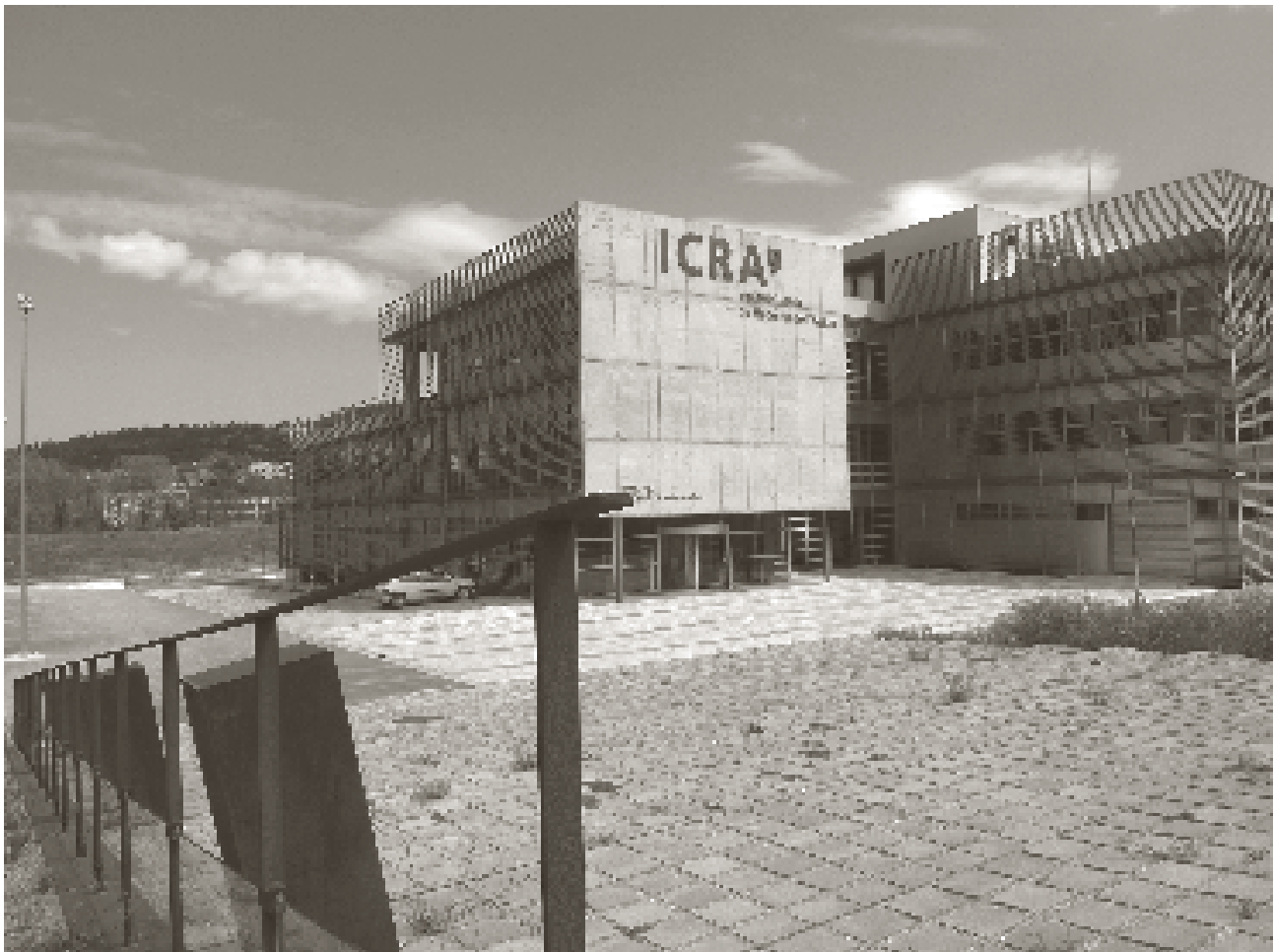
Edifici Institut Català de Recerca de l'Aigua. (Foto: MMV).
