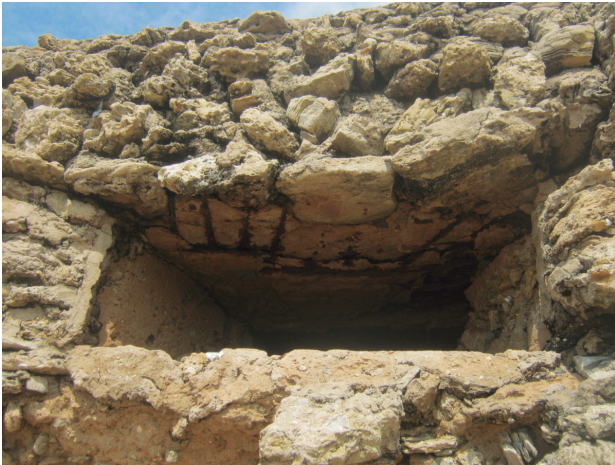
Figura 12. Hormigón de muro estructural con emparchado de bloques y revestimiento de bloques de hormigón de 10x20 cm
