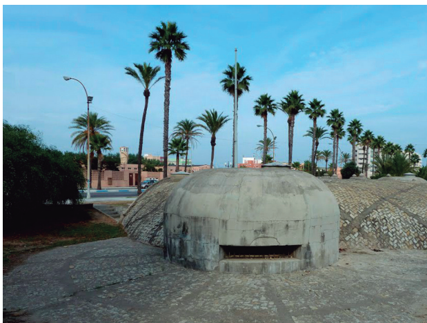
Figura 16. Búnker de cubierta completamente abovedada. Parque Reina Sofía (La Línea de la Concepción)
