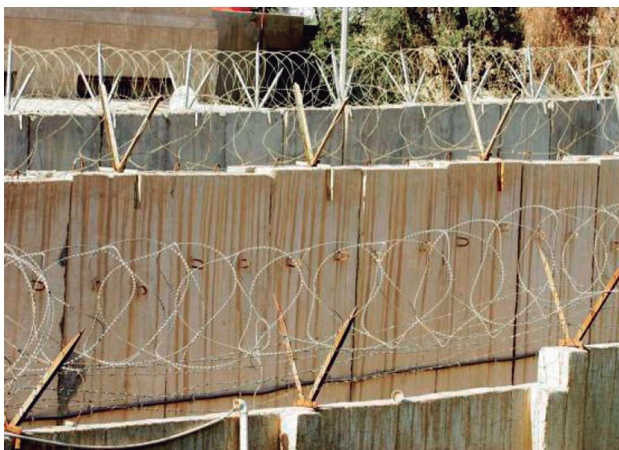
Figura 4. Defensas prefabricadas de la base estadounidense de Adder (Iraq)
