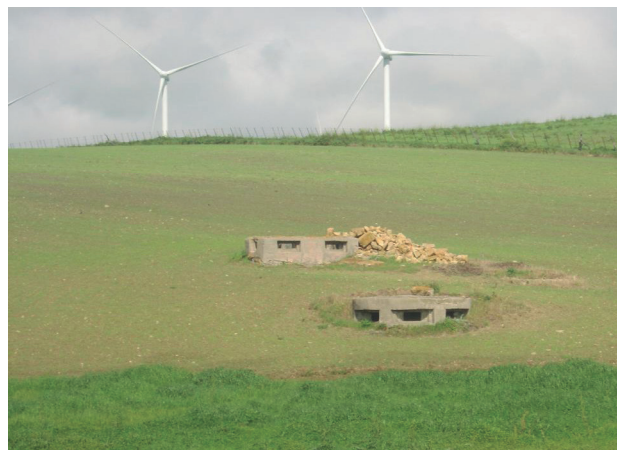
Figura 5. Nidos gemelos de ametralladoras ligeras. Gasolinera Galp (Zahara de los Atunes)
