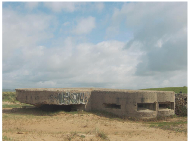
Figura 14. Búnker de cubierta plana. El Palmar (Conil de la Frontera)
