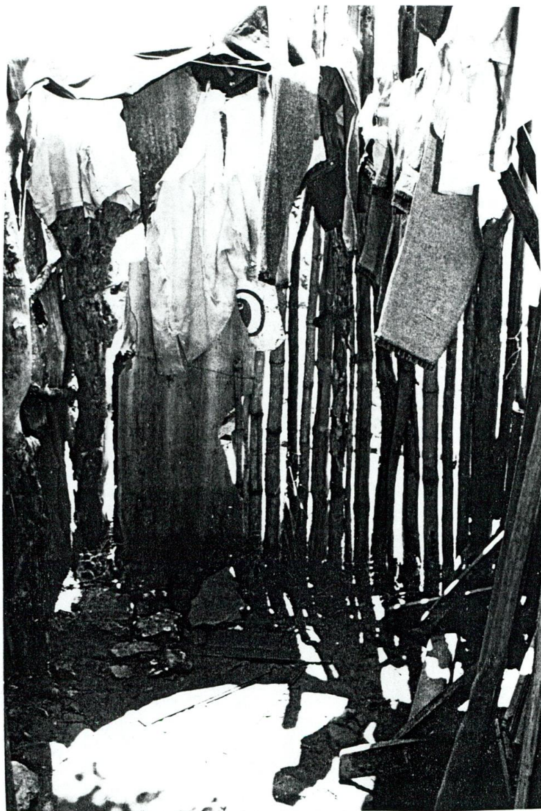
Figura 2. Baño de la vivienda.
