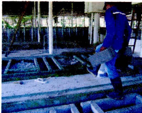
Figura 3. Construcción de hangares con capacidad para 200 cerdas
