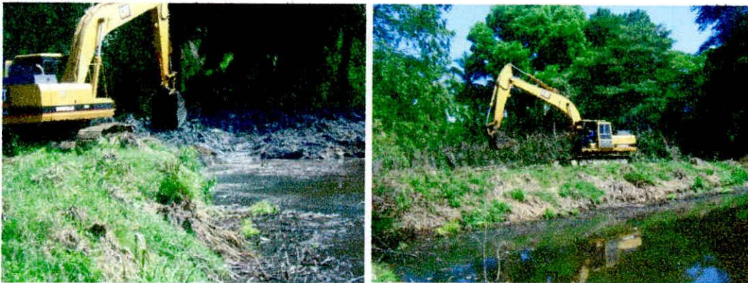
Figura 5. Obras de mantenimiento en laguna de oxidación, extracción de lodo y ampliación de laguna
