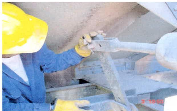
Foto 153. Retiro del pasador que asegura la barra del empuje
