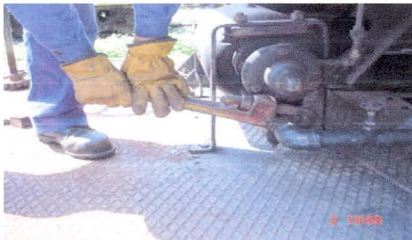
Foto 134. Tuerca en proceso de desmonte
