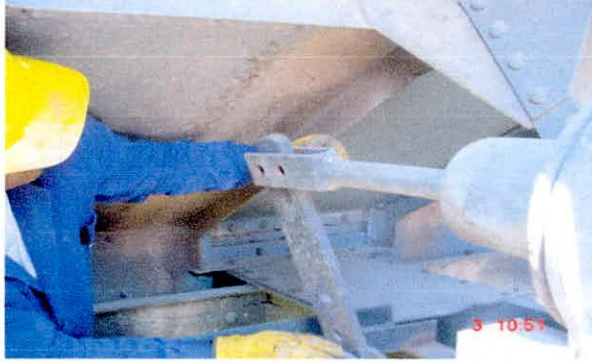
Foto 154. Proceso de retiro de la barra de empuje
