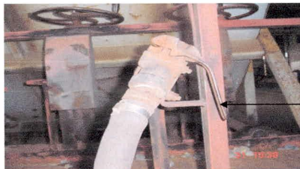
Foto 113. Llave angular en posición cerrada
