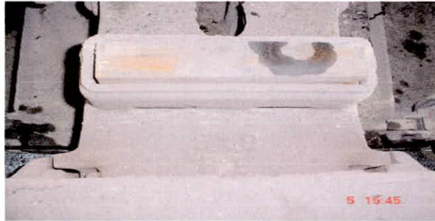
Foto 60. Descansos laterales a fricción
