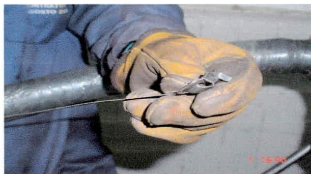
Foto 187. Hebilla asegurada por el dobléz
