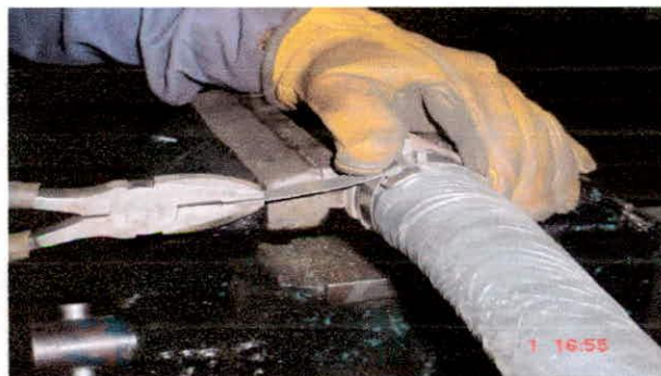
Foto 191. Extremo libre de la cinta metálica y se hala con alicate
