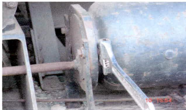
Foto 179. Retiro de los tornillos
