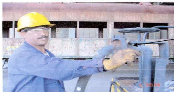
Foto 123. Llave angular en posición cerrada
