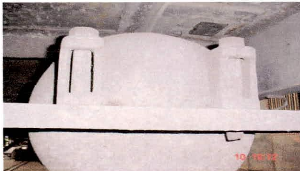
Foto 174. Retiro de tornillos que sujetan el depósito a la estructura
