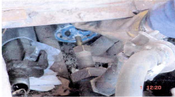
Foto 124. Cierre del suministro de aire
